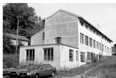
Entrepôt industriel (usine de 1946). Phot. Laurent Poupard IVR43_19913901282Z
