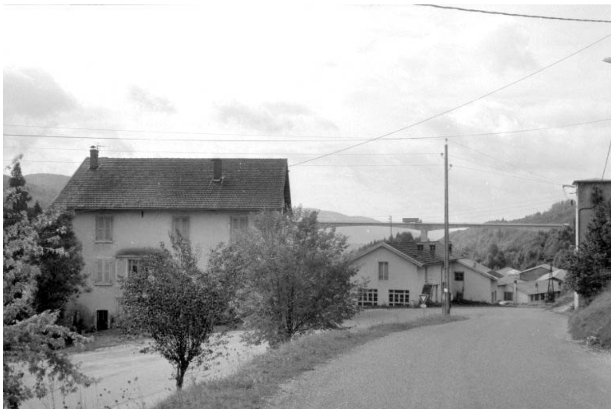
Usines et logement depuis le nord.
