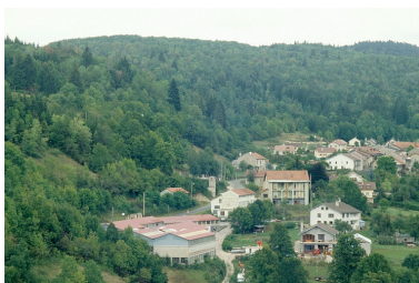
Vue d'ensemble depuis le sud. Phot. Laurent Poupard IVR43_19913901276ZA
