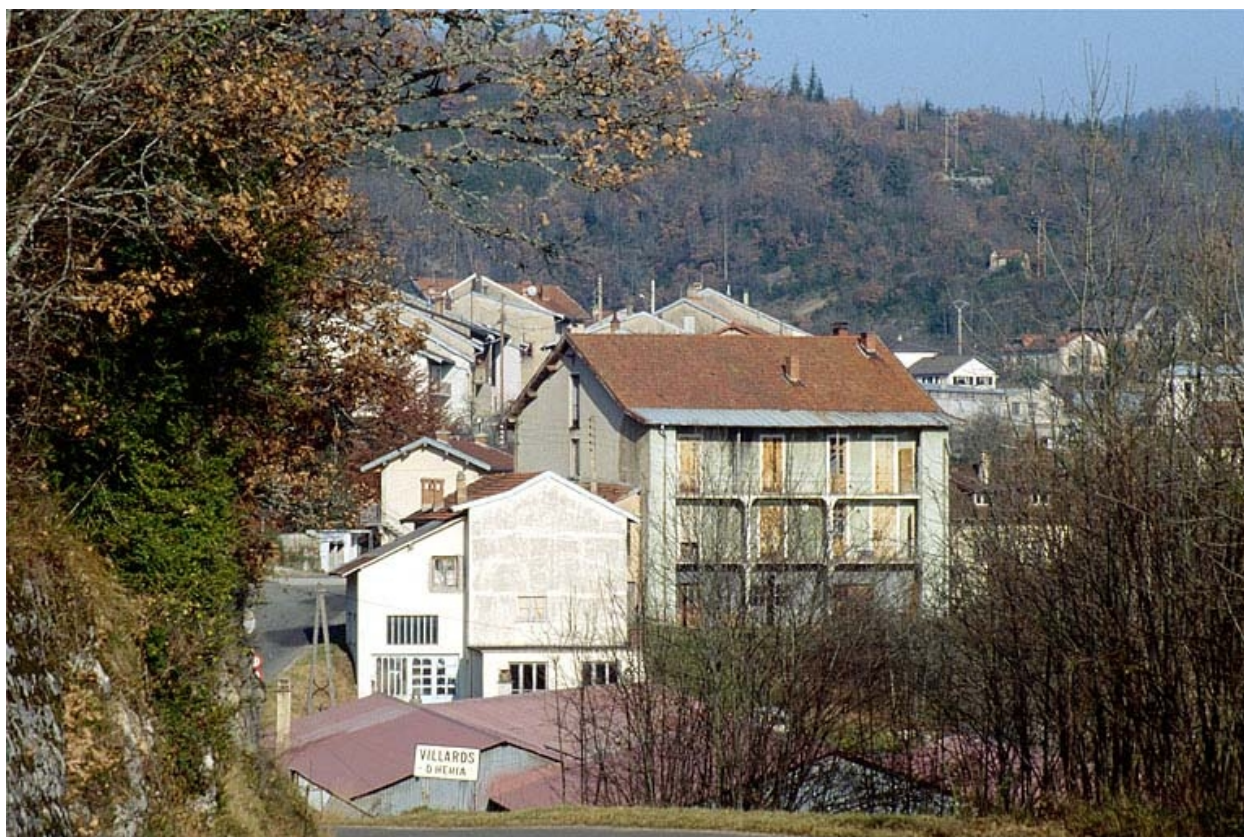
Usines et logement depuis le sud.
