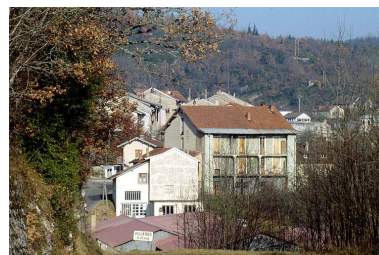
Usines et logement depuis le sud. Phot. Laurent Poupard IVR43_19913901278ZA
