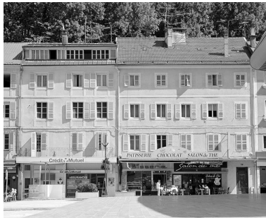
élévation antérieure Phot. Yves Sancey IVR43_20033900312X
