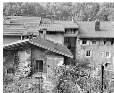
Ancien atelier : mur pignon oriental. Phot. Yves Sancey IVR43_20033900311X
