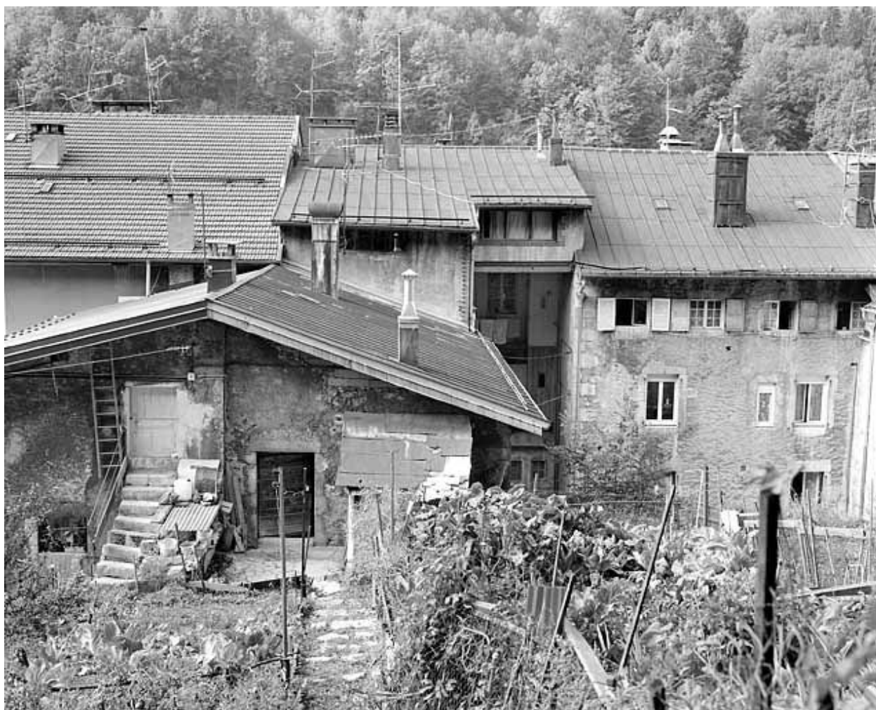
Ancien atelier : mur pignon oriental.
