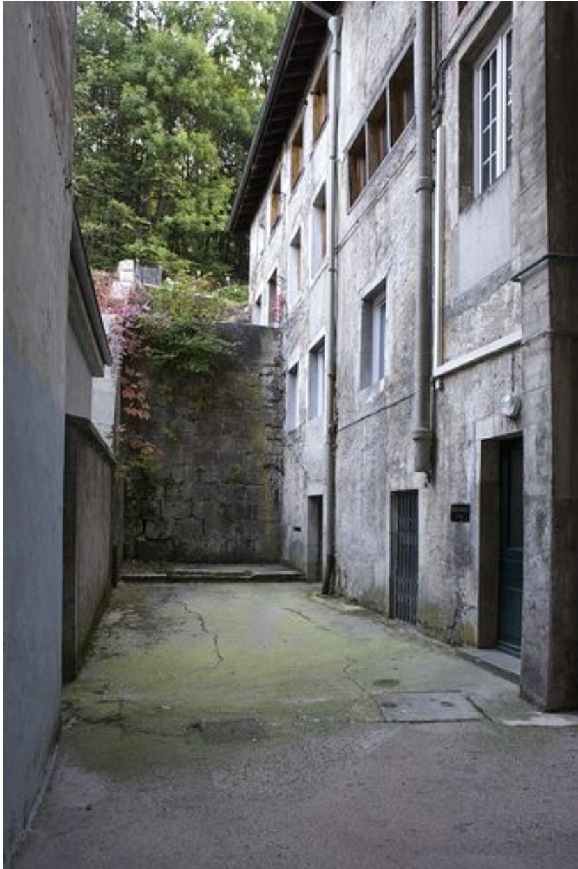
Cour, ancien atelier et mur de soutènement.
