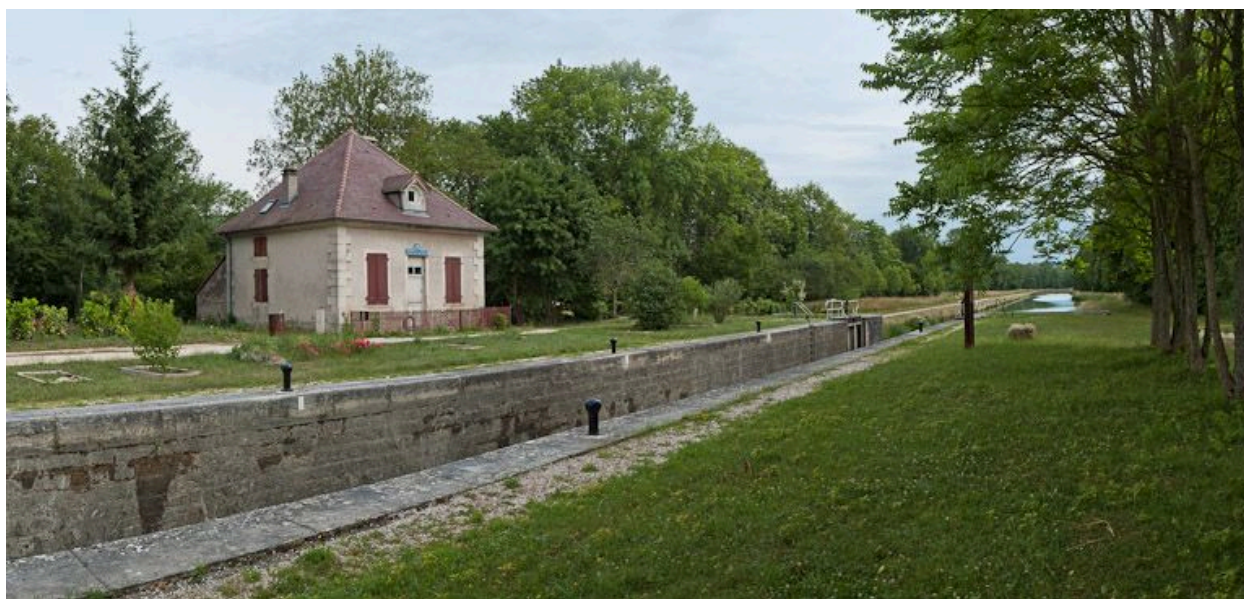
Vue d'ensemble du site d'écluse.
