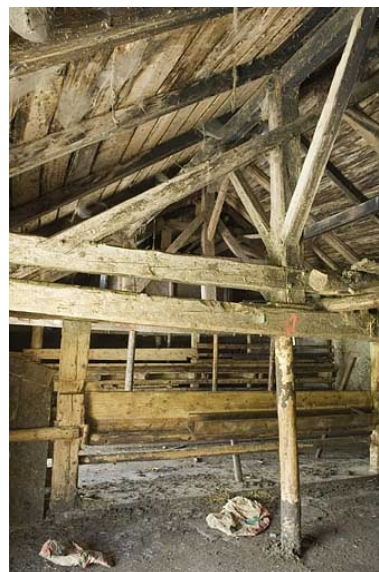
Détail de la charpente. Phot. Jérôme Mongreville IVR43_20092500825NUC2A
