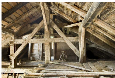
Vue générale de la charpente et, au fond, la porte ouvrant sur la chambre du berger. Phot. Jérôme Mongreville IVR43_20092500824NUC2A
