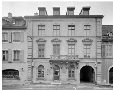
Façade sur rue. Phot. Jérôme Mongreville IVR43_19872501257V
