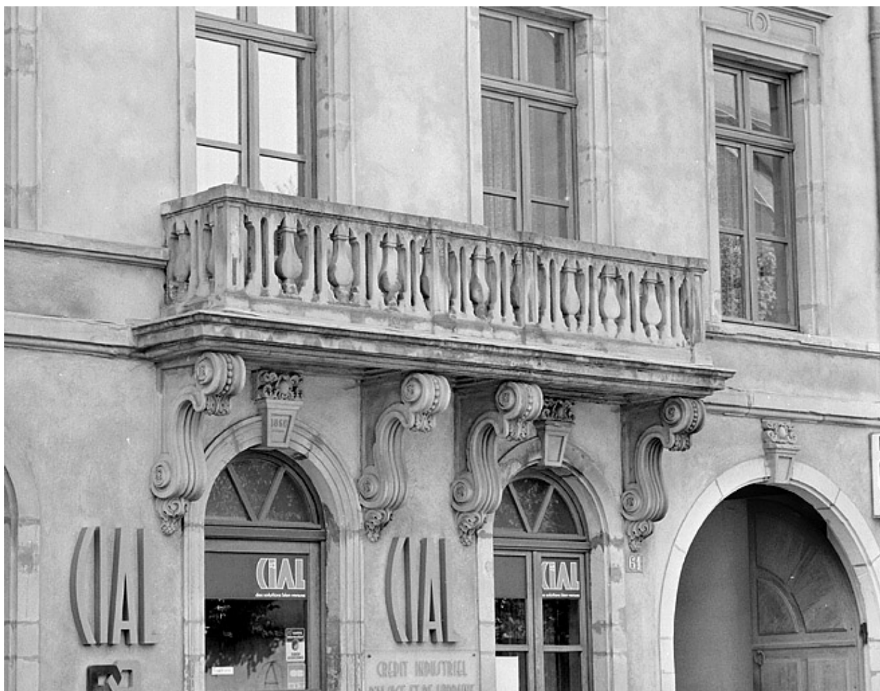
Façade sur rue. Détail du balcon.
