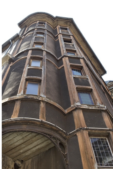
Vue d'ensemble de la cage d'escalier en pan de bois. Phot. Yves Sancey IVR43_20102500922NUC2A
