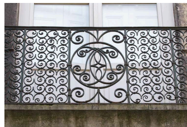
Logis principal, façade sur cour : détail de la ferronnerie d'un garde-corps. Phot. Yves Sancey IVR43_20102500921NUC2A
