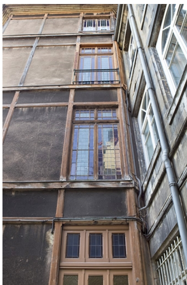
Détail de la paroi de la cage d'escalier en pan de bois. Phot. Yves Sancey IVR43_20102500914NUC2A
