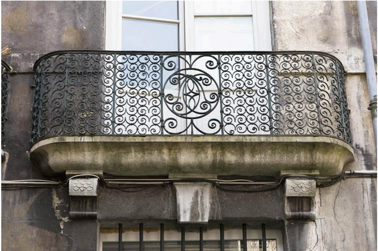
Logis principal, façade sur cour : détail d'un garde-corps.
