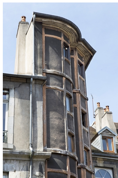
Détail de la partie supérieure de la cage d'escalier en pan de bois. Phot. Yves Sancey IVR43_20102500918NUC2A
