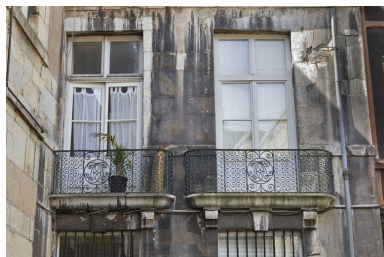
Logis principal, façade sur cour : détail des deux garde-corps. Phot. Yves Sancey IVR43_20102500920NUC2A
