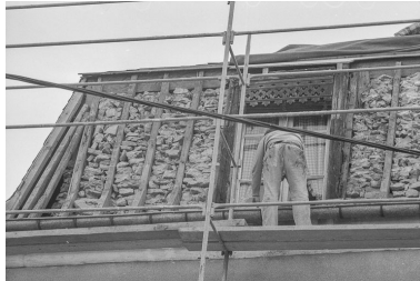
Les combles. Phot. Bernard Lardière IVR43_19797000196Z
