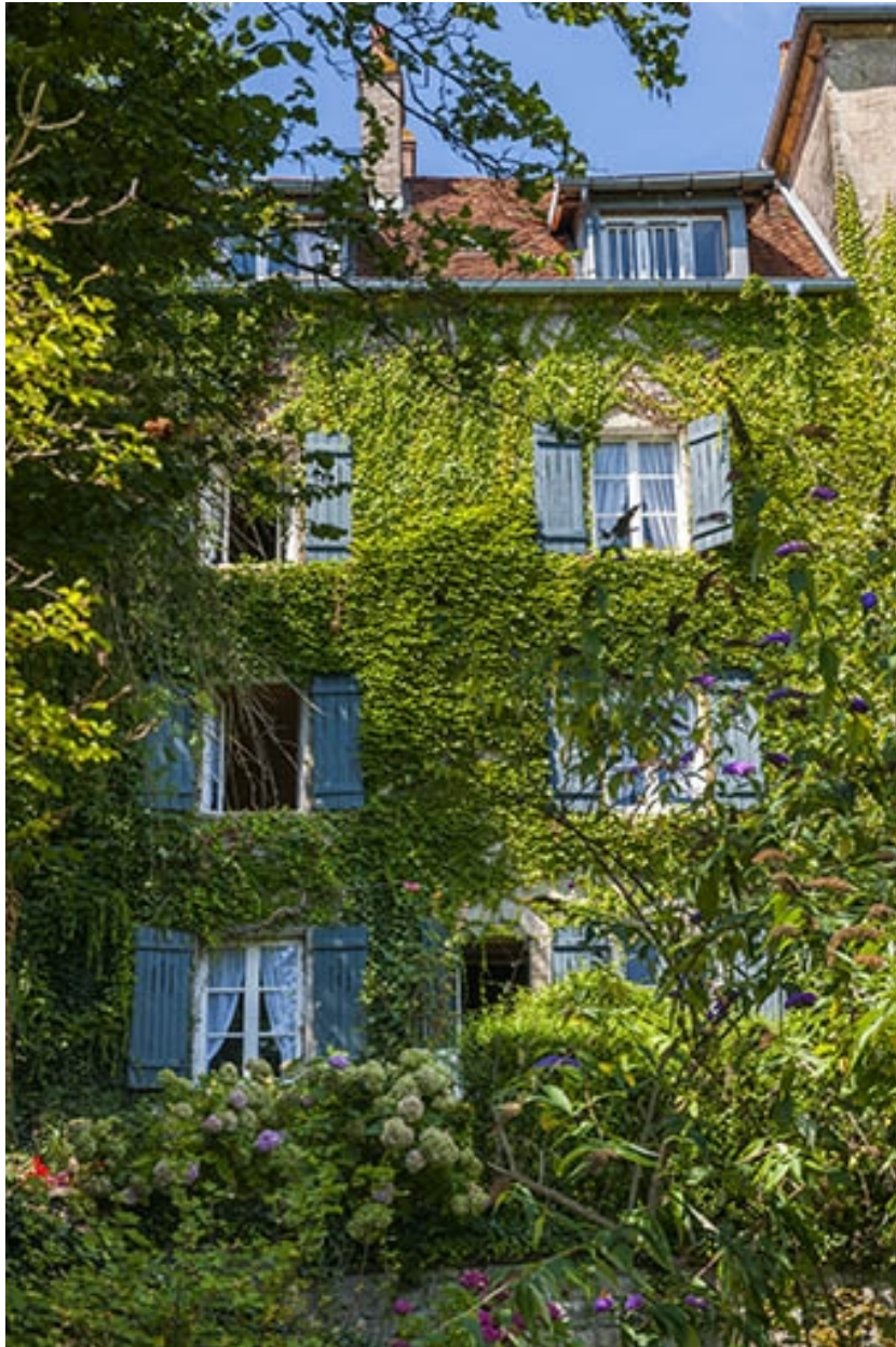
Façade postérieure, côté canal du Moulin.
