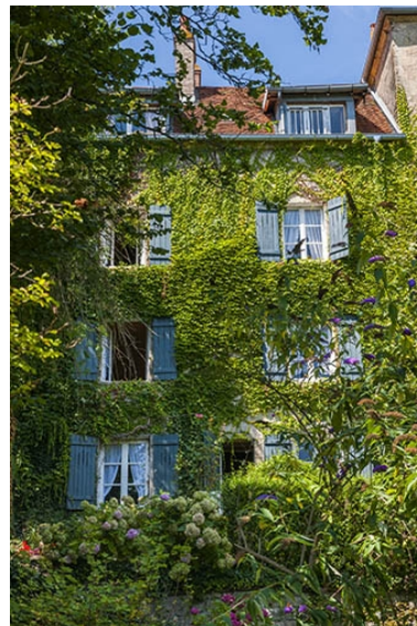
Façade postérieure, côté canal du Moulin. Phot. Jérôme Mongreville IVR43_20127000495NUC4A
