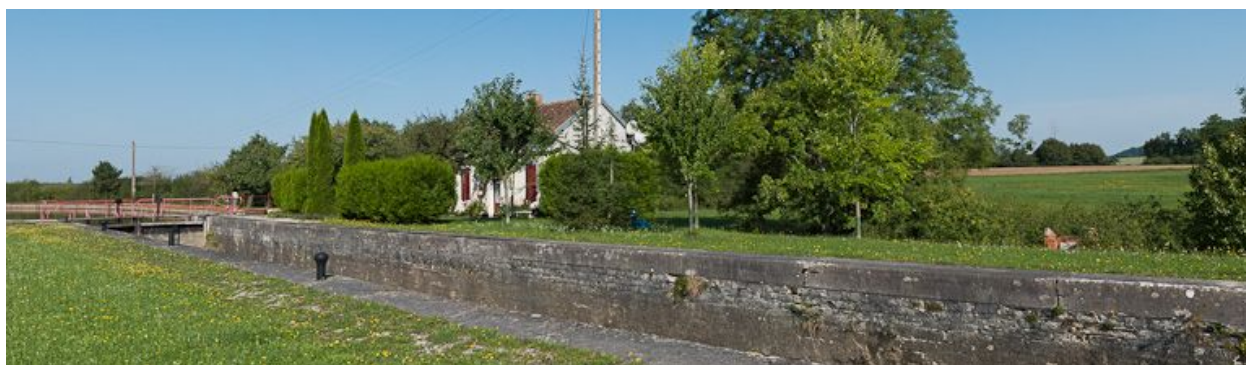
Vue d'ensemble du site d'écluse.
