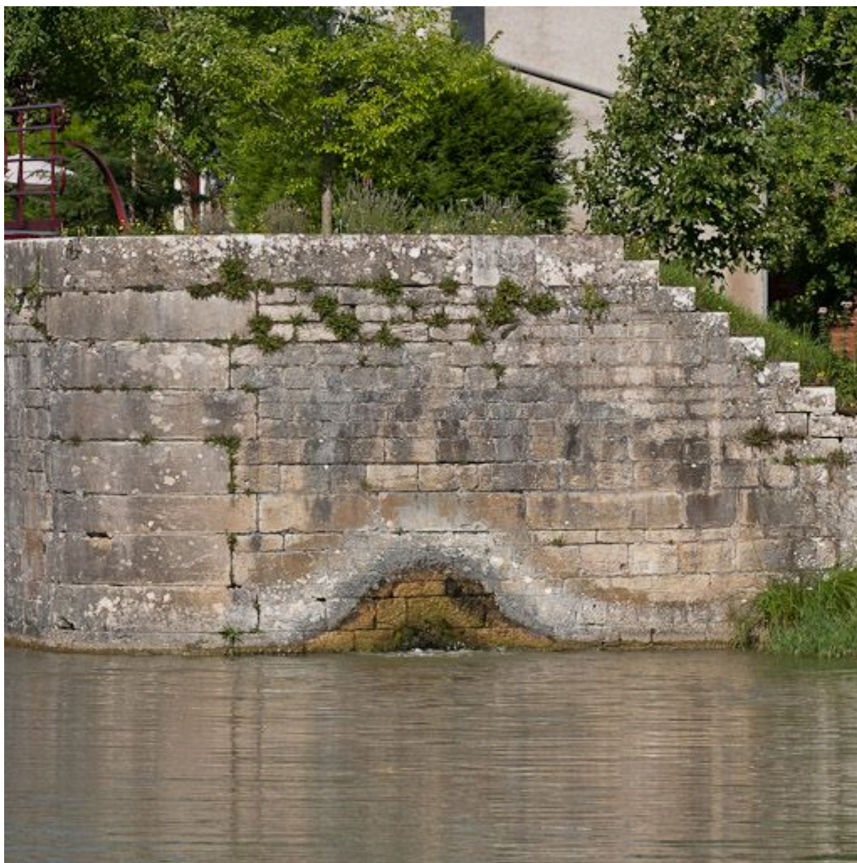
Détail de l'aqueduc Freycinet.
