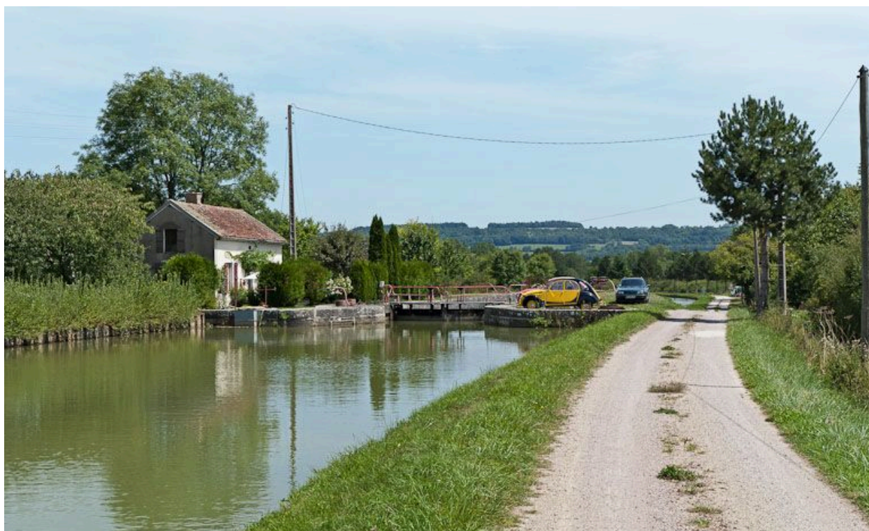
Vue du site d'écluse depuis l'amont.
