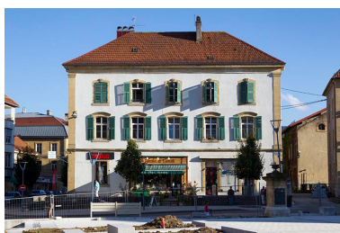
Façade antérieure (2013). Phot. Yves Sancey IVR43_20132502259NUC2A
