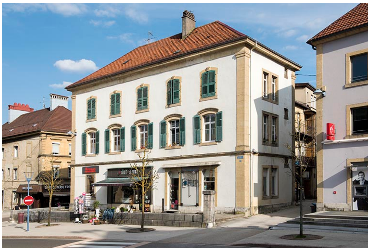
Façades antérieure et latérale droite.
