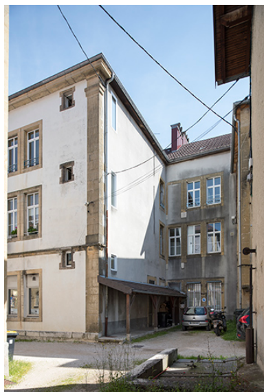
Façades postérieure et latérale droite.
