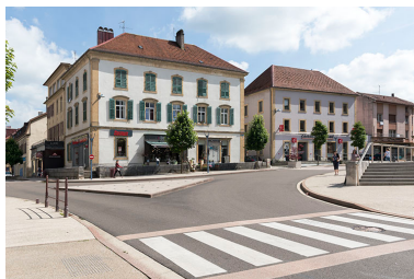
Vue d'ensemble, depuis le nord. Phot. Sonia Dourlot IVR43_20182500952NUC4A
