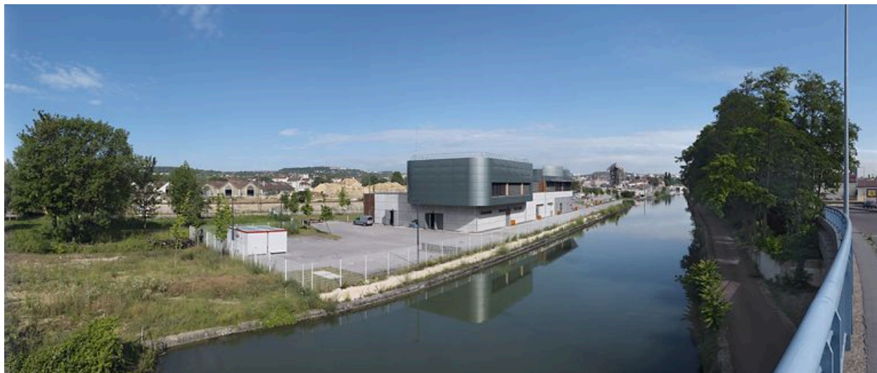
Le poste d'aiguillage vu du pont permettant le passage des boulevard John Kennedy et Maillard.
