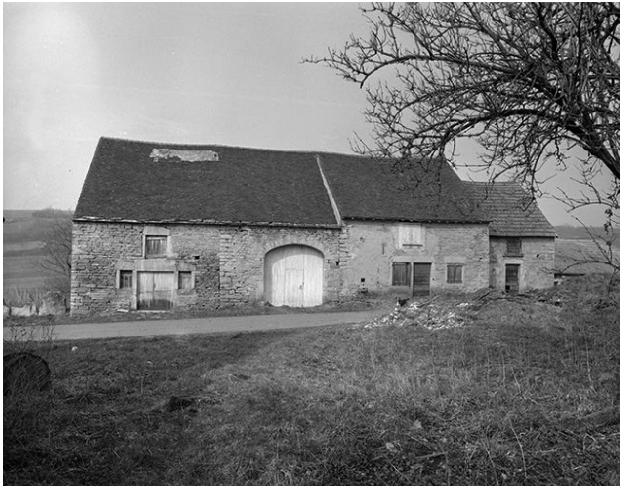
Façade antérieure, vue de face.
