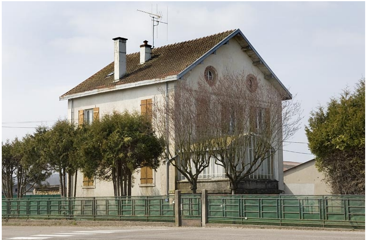
Logement patronal depuis l'est.
