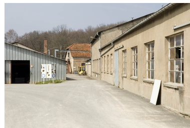
Façade ouest d'un atelier de menuiserie.
