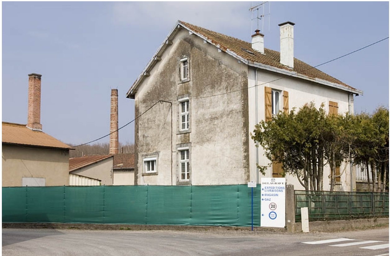
Logement patronal depuis le sud.
