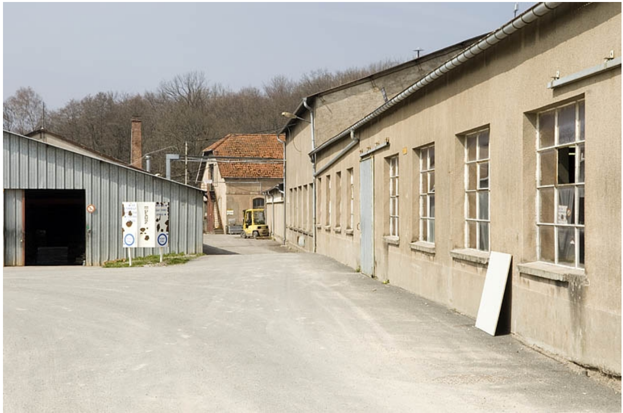
Façade ouest d'un atelier de menuiserie.
