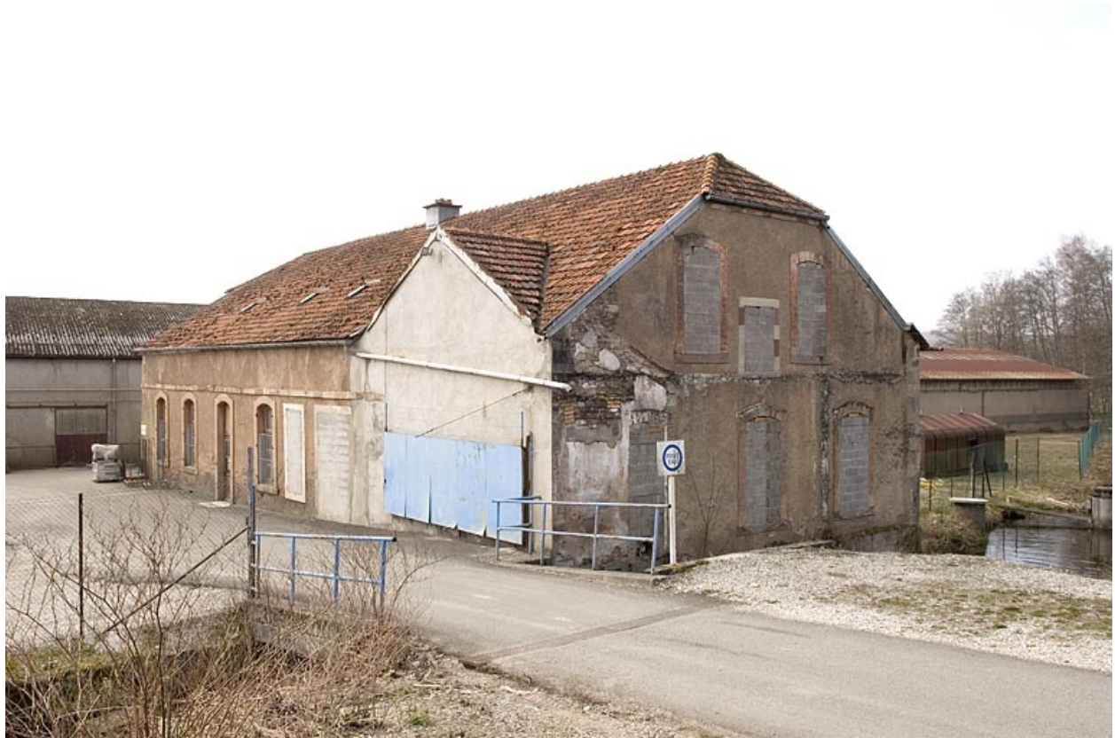
Moulin d'aval. Vue depuis l'est.
