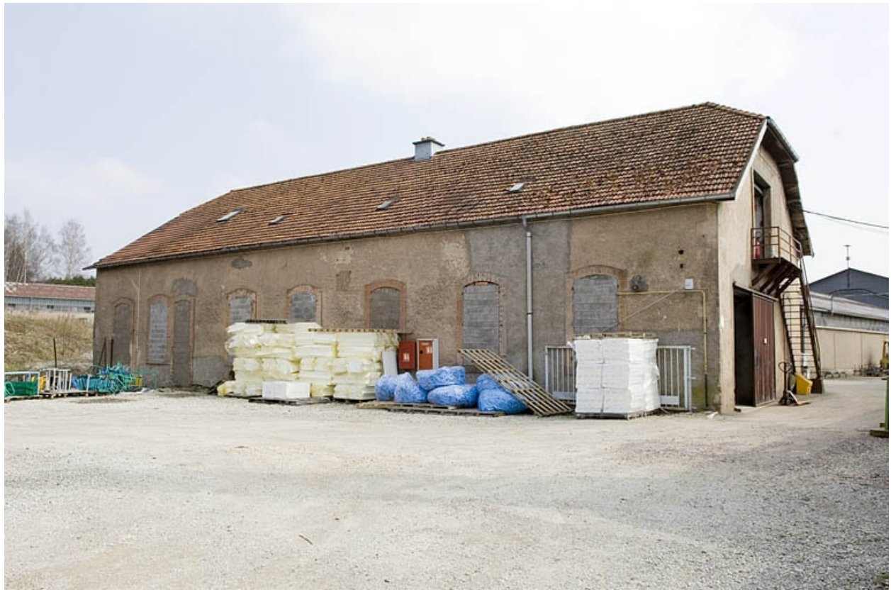
Moulin d'aval. Vue de trois quarts arrière.
