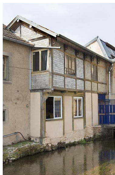
Façade est des bureaux. Phot. Jérôme Mongreville IVR43_20097000474NUC2A
