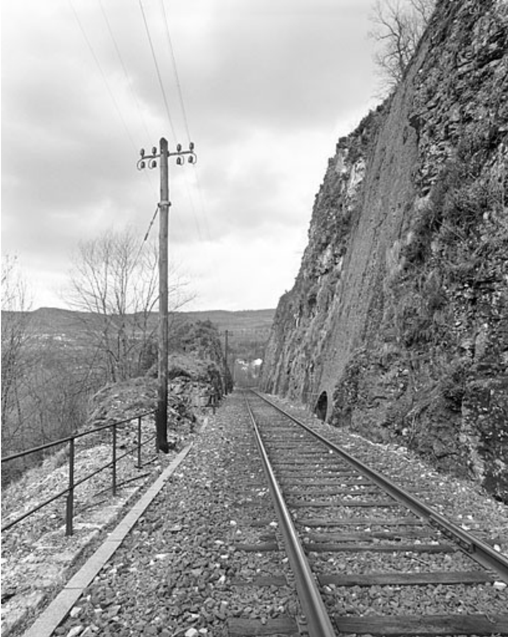
Descente d'eau du deuxième aqueduc, vue depuis le côté Andelot-en-Montagne (sud-est).
