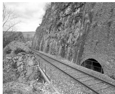
Deuxième aqueduc et sa descente d'eau. Phot. Yves Sancey IVR43_20053900824X
