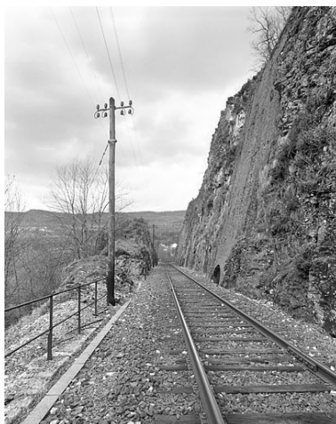
Descente d'eau du deuxième aqueduc, vue depuis le côté Andelot-en-Montagne (sud-est). Phot. Yves Sancey IVR43_20053900823X
