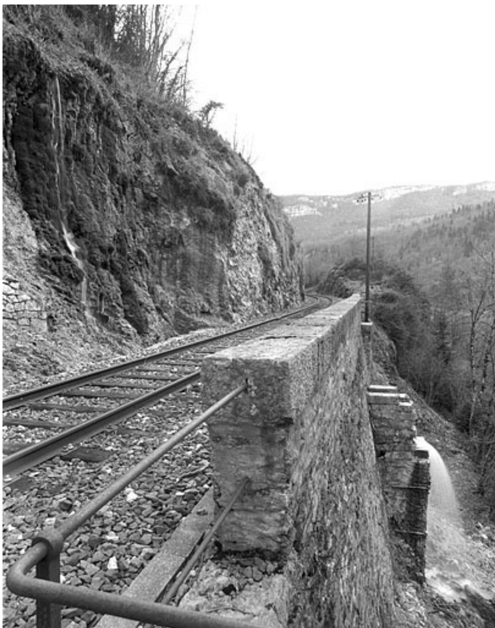
Mur et premier aqueduc, vus en enfilade depuis le côté La Cluse (ouest).
