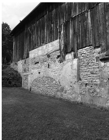
Façade sud de l'atelier de fabrication.
