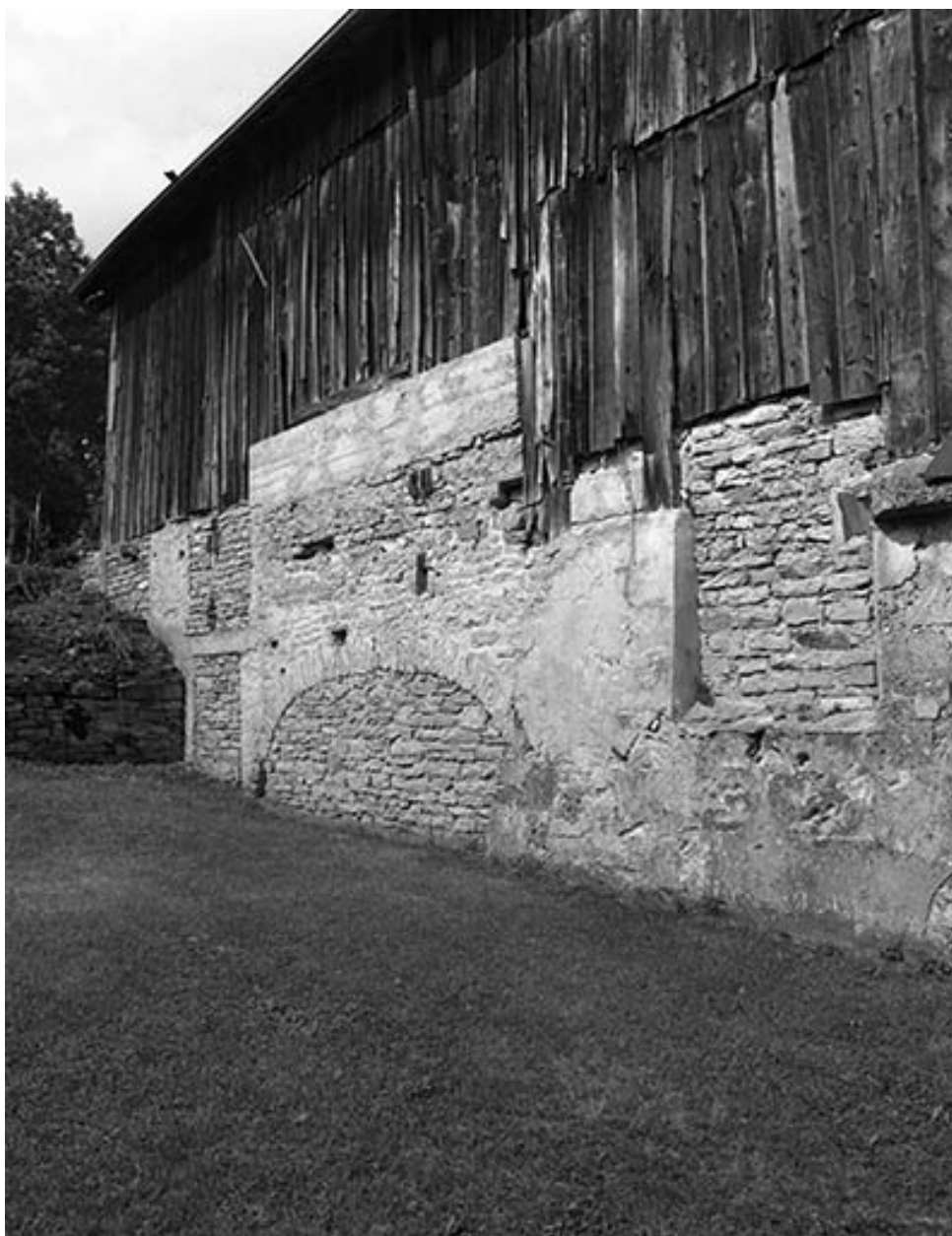
Façade sud de l'atelier de fabrication.
