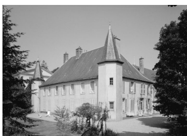
Corps de logis principal. Phot. Michel Rosso IVR26_19862100829V
