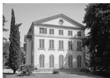
Pavillon ouest, élévation ouest. Phot. Michel Rosso IVR26_19862100825V
