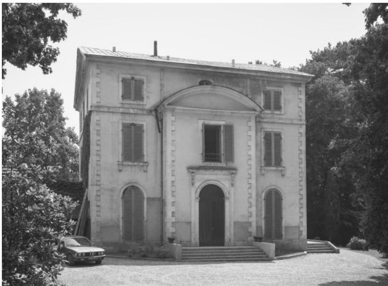
Pavillon ouest, façade antérieure.
