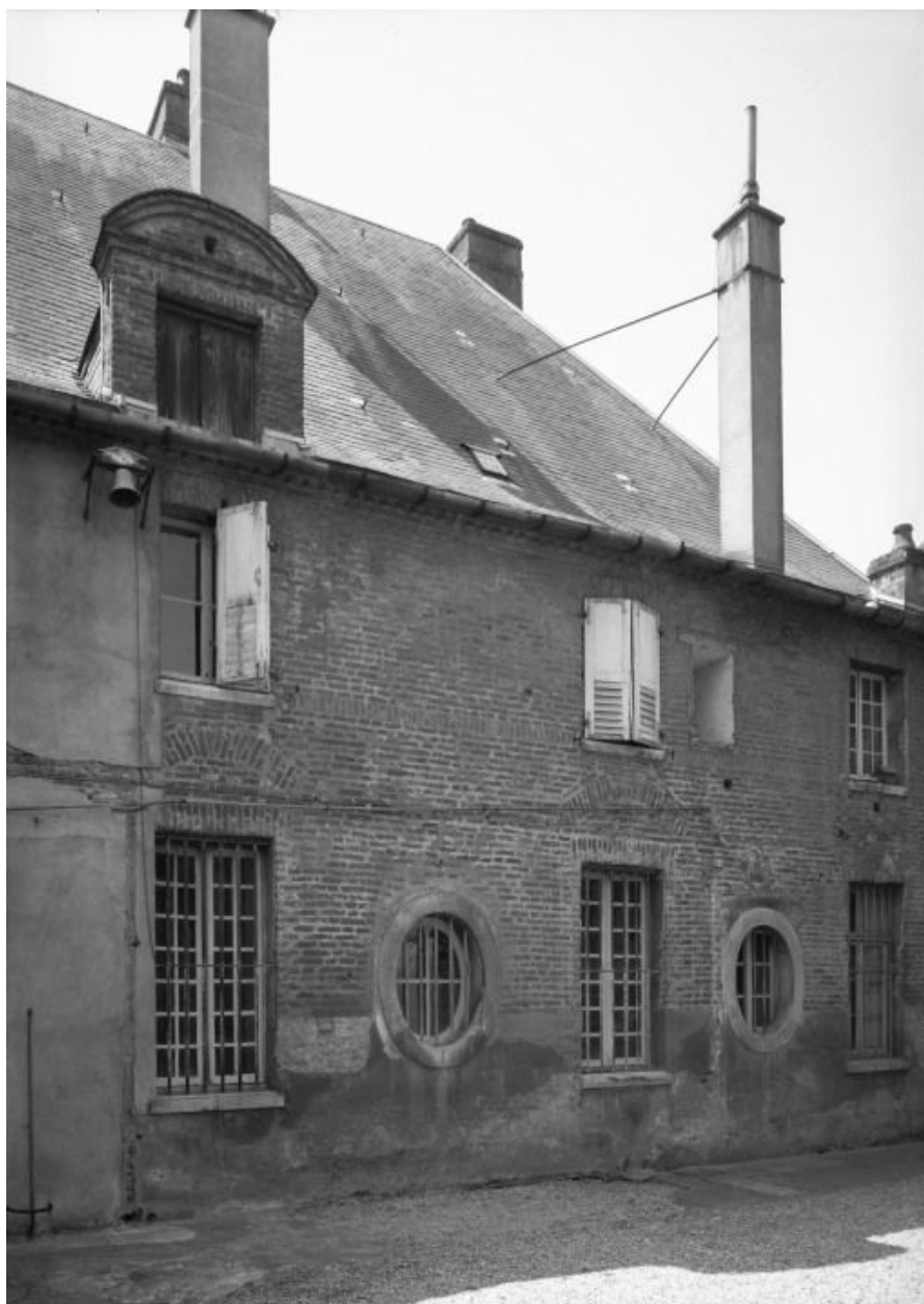
Mur postérieur du corps de logis.
