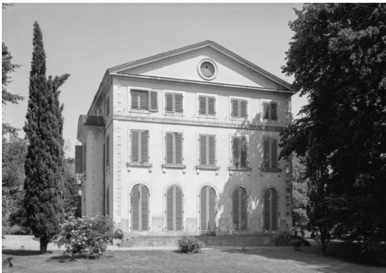
Pavillon ouest, élévation ouest.
