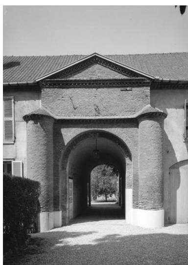
Aile nord, corps de passage. Phot. Michel Rosso IVR26_19862100827V
