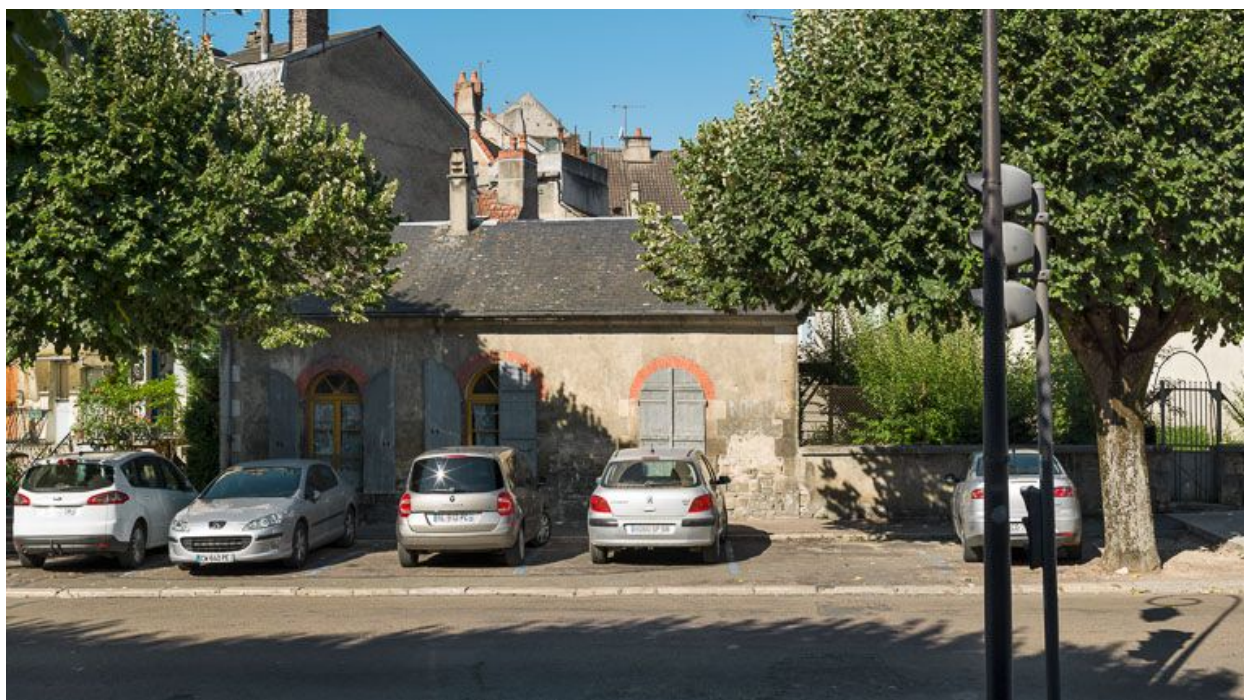
L'ancienne maison éclusière, de face.
