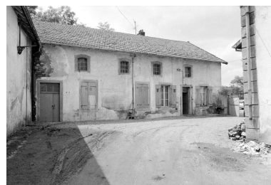
La conciergerie en 1980.SRI. Enquête régionale sur les bâtiments industriels (1979-1981). Phot. Jack Dumont IVR43_19809000031Z
