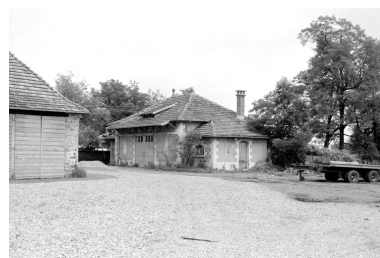
Garage en 1980.SRI. Enquête régionale sur les bâtiments industriels (1979-1981).
