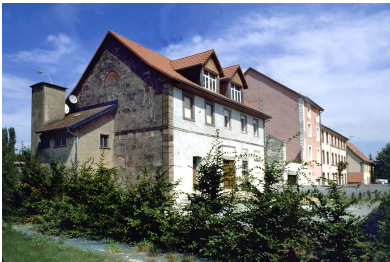
Façade postérieure des ateliers de fabrication.
