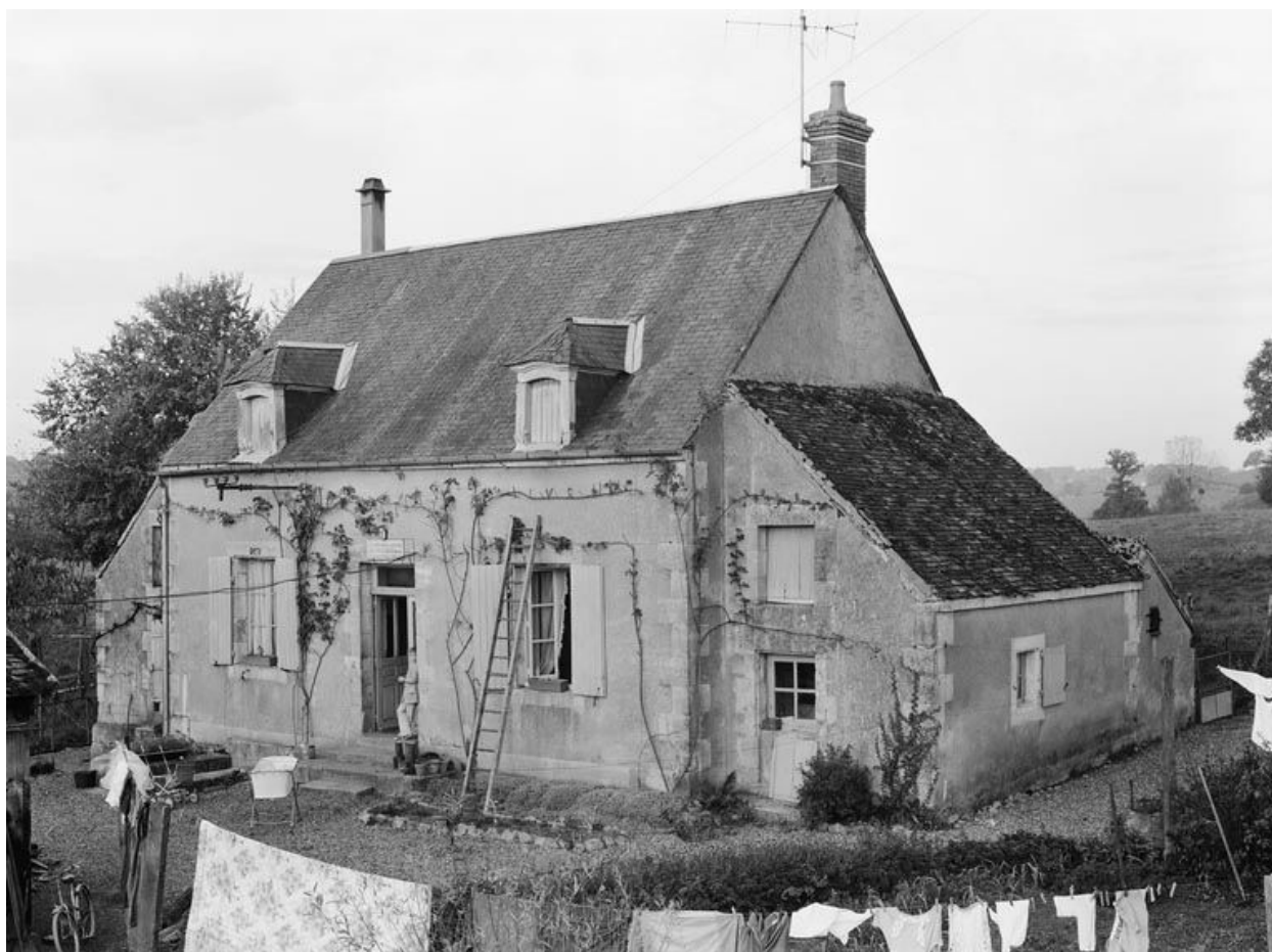
Vue d'ensemble de la maison éclusière.
