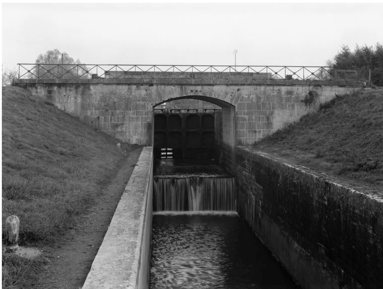
Le sas et le pont sur écluse.
