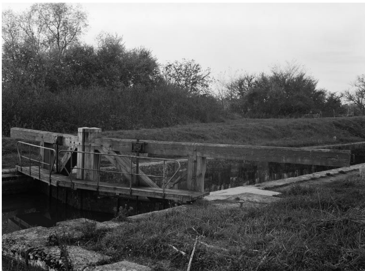
Portes en bois de l'écluse.
