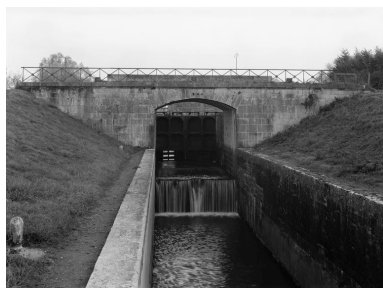
Le sas et le pont sur écluse. Phot. non renseigné IVR26_19755800796V
