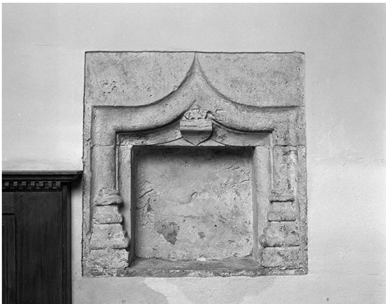
Intérieur : niche du collatéral gauche.
