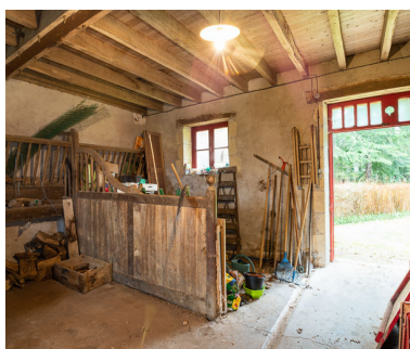
Vue intérieure de l'ancienne écurie au rez-de-chaussée. Phot. Pierre-Marie Barbe-Richaud IVR26_20195800024NUC4AQ
