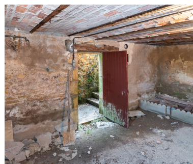
Vue intérieure de la cave. Phot. Pierre-Marie Barbe-Richaud IVR26_20195800025NUC4A
