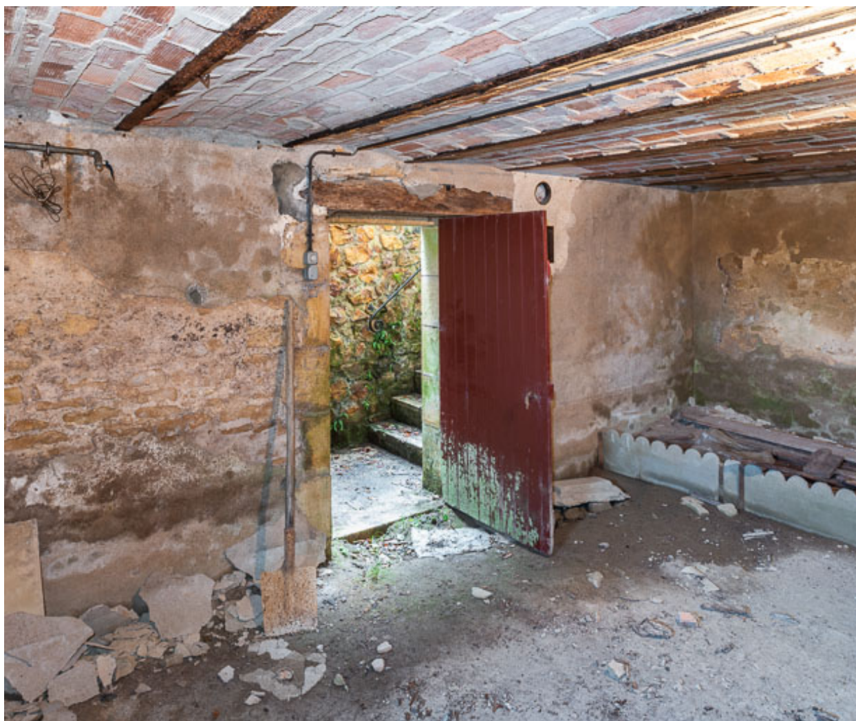
Vue intérieure de la cave.
