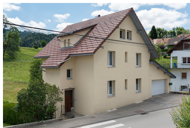
Façades antérieure et latérale gauche.
