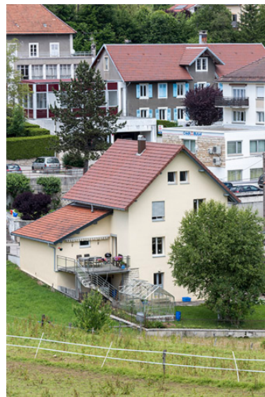
Façades postérieure et latérale droite.
