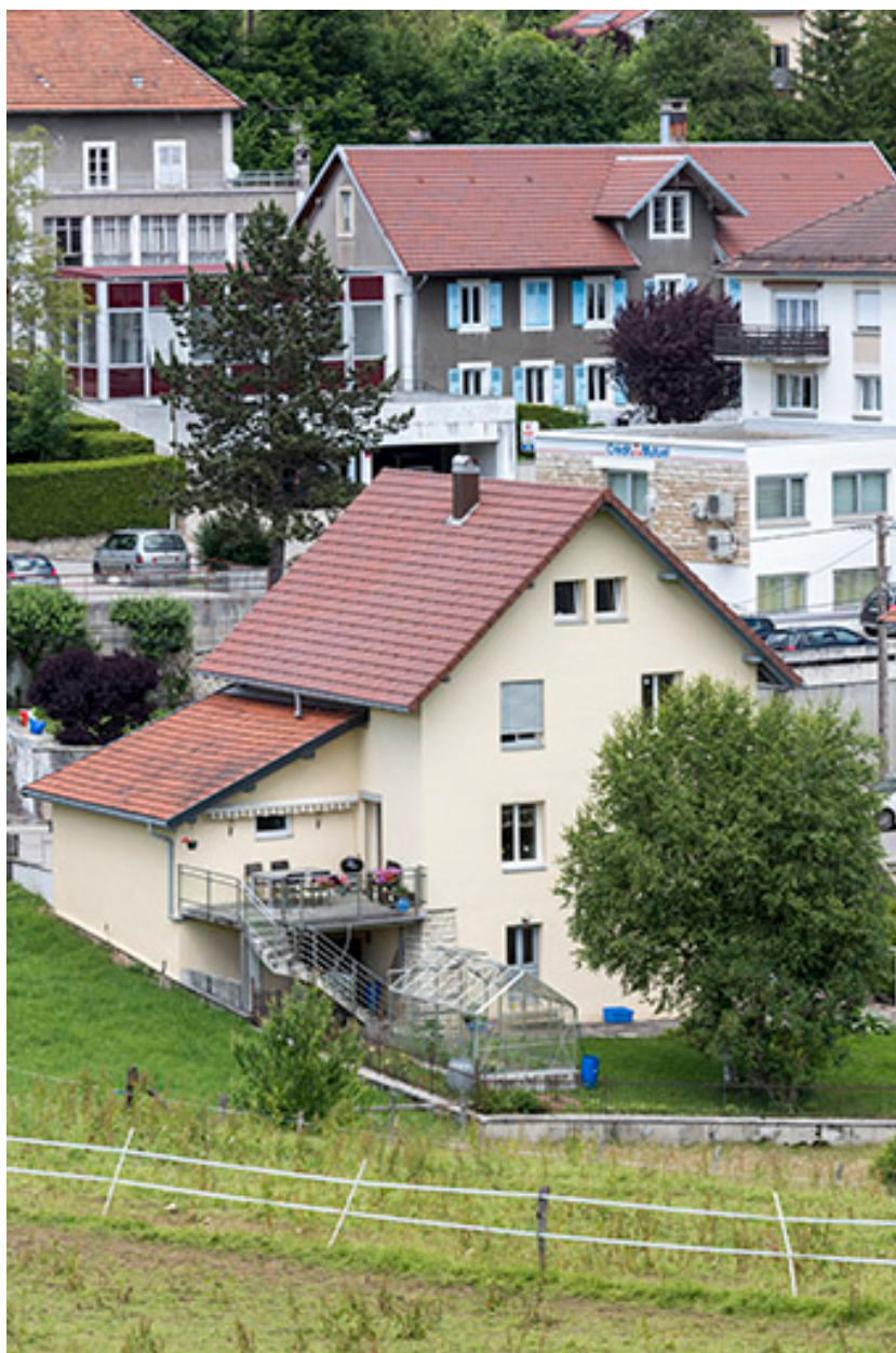
Façades postérieure et latérale droite.
