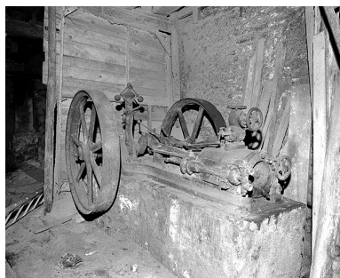
Vue d'ensemble de la machine à vapeur.
