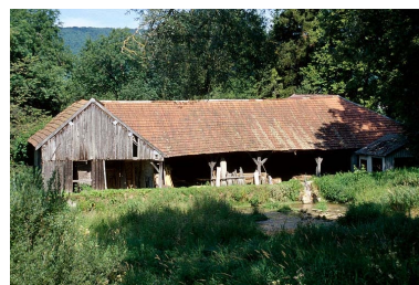
Atelier de fabrication depuis l'est. Phot. Yves Sancey IVR43_19973901235ZA
