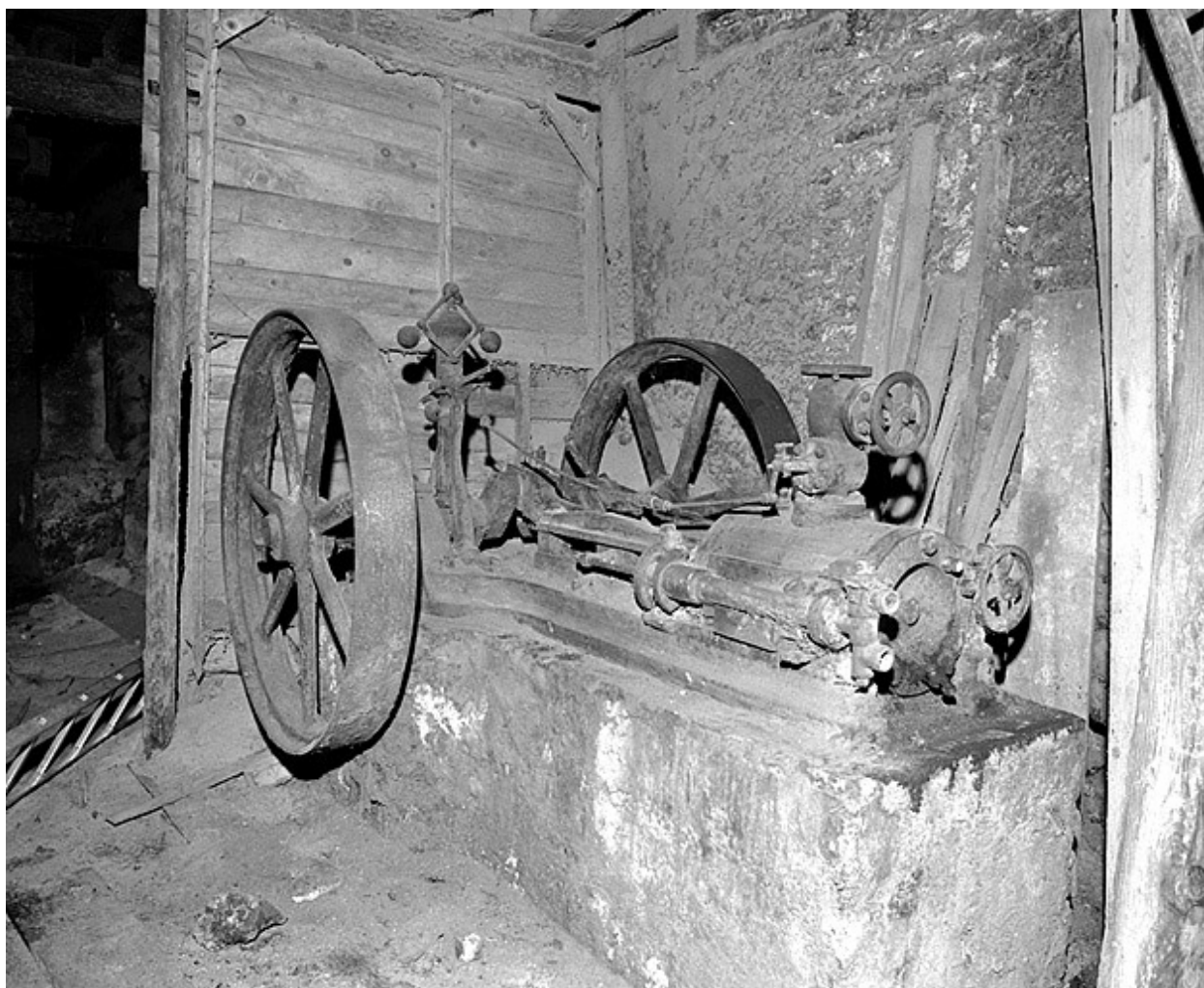
Vue d'ensemble de la machine à vapeur.
