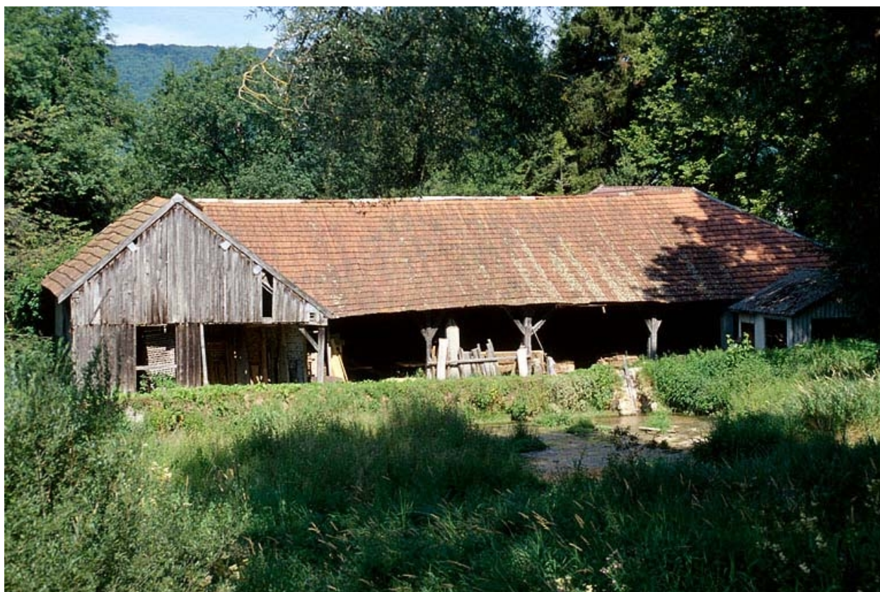
Atelier de fabrication depuis l'est.
