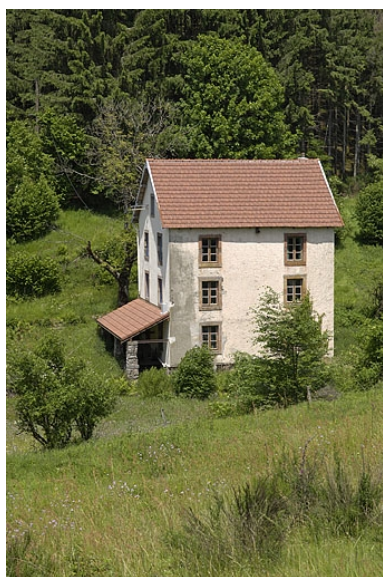
Façade sud du moulin. Phot. Jérôme Mongreville IVR43_20057000262NUCA
