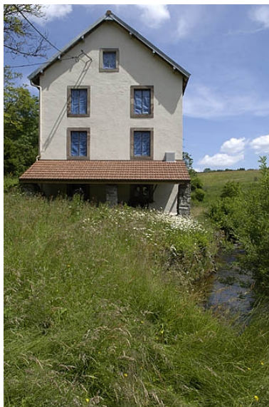
Façade nord-ouest et appentis abritant la turbine. Phot. Jérôme Mongreville IVR43_20057000268NUCA
