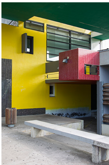
Détail constructif à droite de l'entrée. Phot. Sonia Dourlot IVR43_20142500813NUC2A
