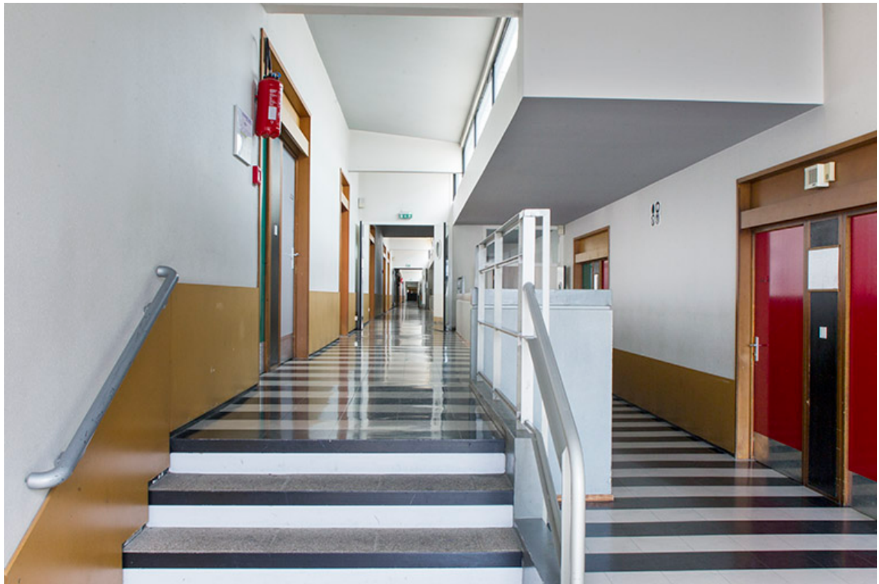
Couloir du bâtiment d'externat.
