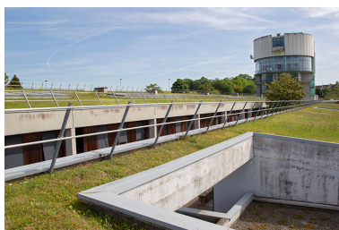
Terrasses et tour vue du sud-ouest. Phot. Sonia Dourlot IVR43_20142500831NUC2A
