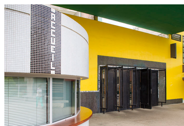
Détail de l'entrée vue de trois-quart sud. Phot. Sonia Dourlot IVR43_20142500812NUC2A
