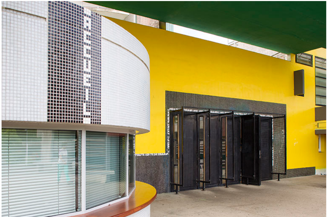
Détail de l'entrée vue de trois-quart sud.
