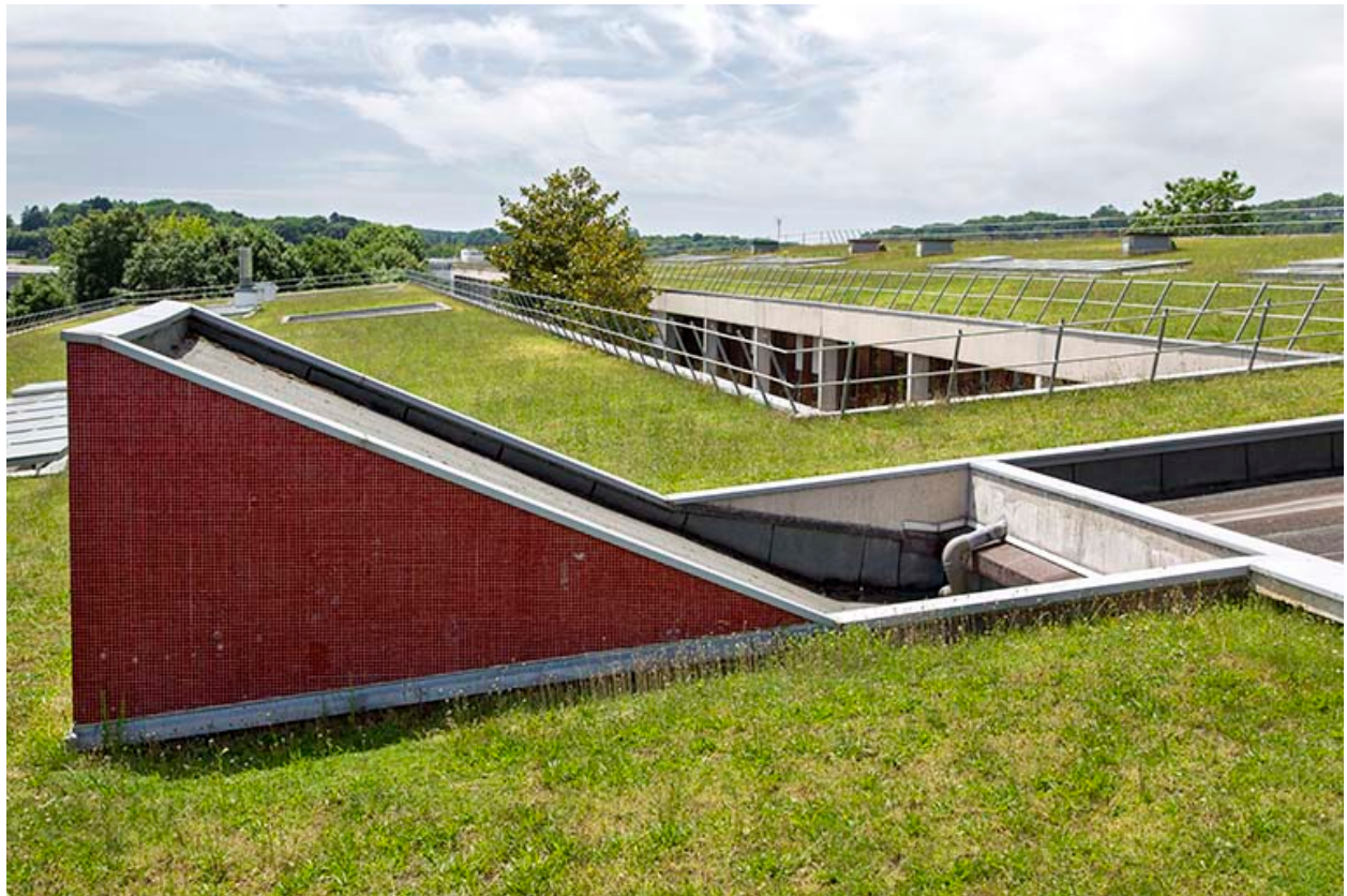
Détail de lucarne sur la terrasse.
