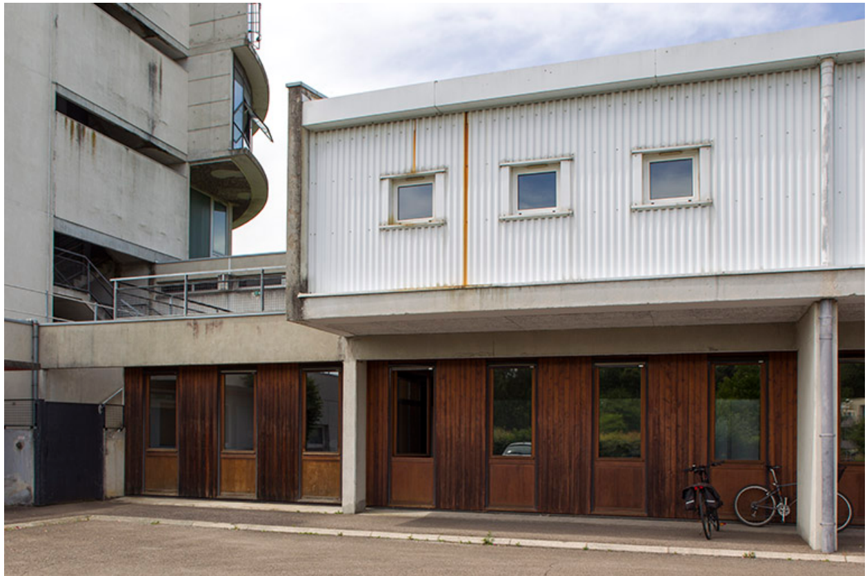
Entrée au rez-de-chaussée du bâtiment "agencement".
