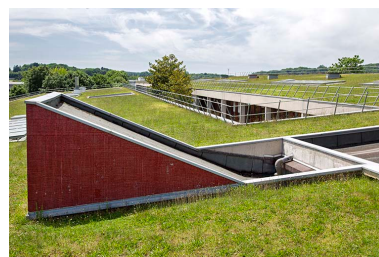
Détail de lucarne sur la terrasse. Phot. Sonia Dourlot IVR43_20142500834NUC2A
