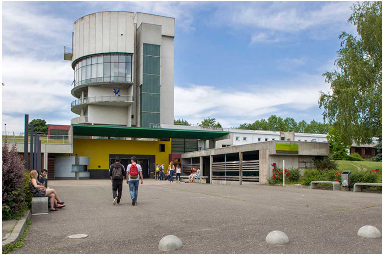
Face à l'entrée et la tour.
