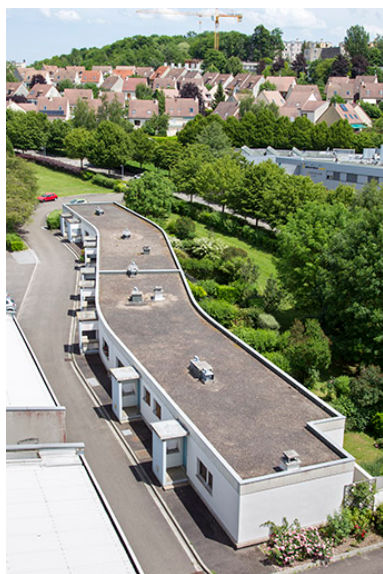
Depuis la tour, vue sur les logements. Phot. Sonia Dourlot IVR43_20142500859NUC2A
