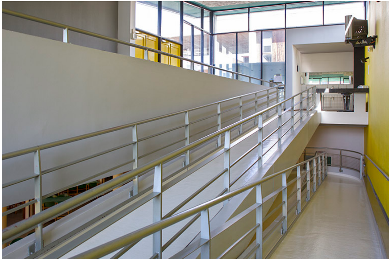
Détail de circulation intérieure.
