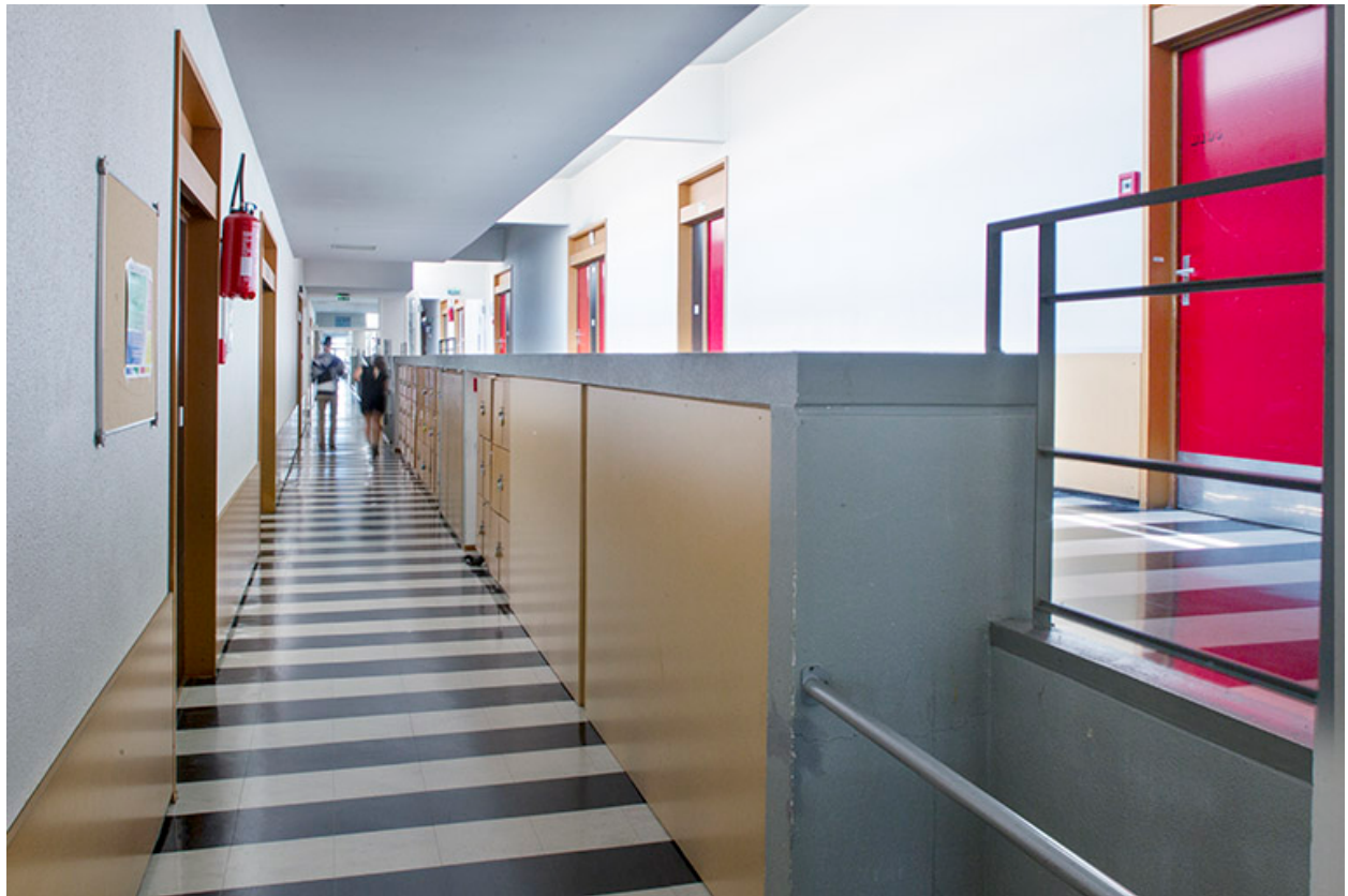
Couloir du bâtiment d'externat.
