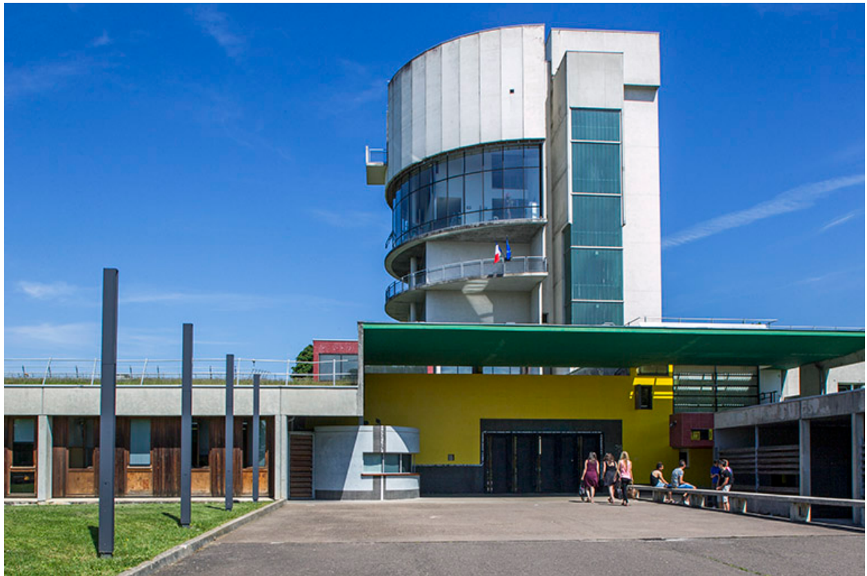
Face à l'entrée et la tour.
