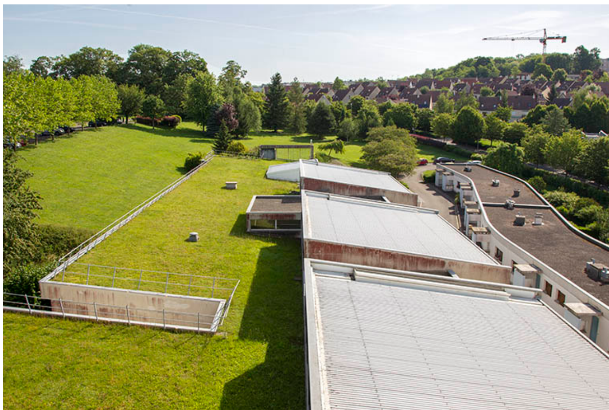
Vue d'ensemble des terrasses au nord-est.
