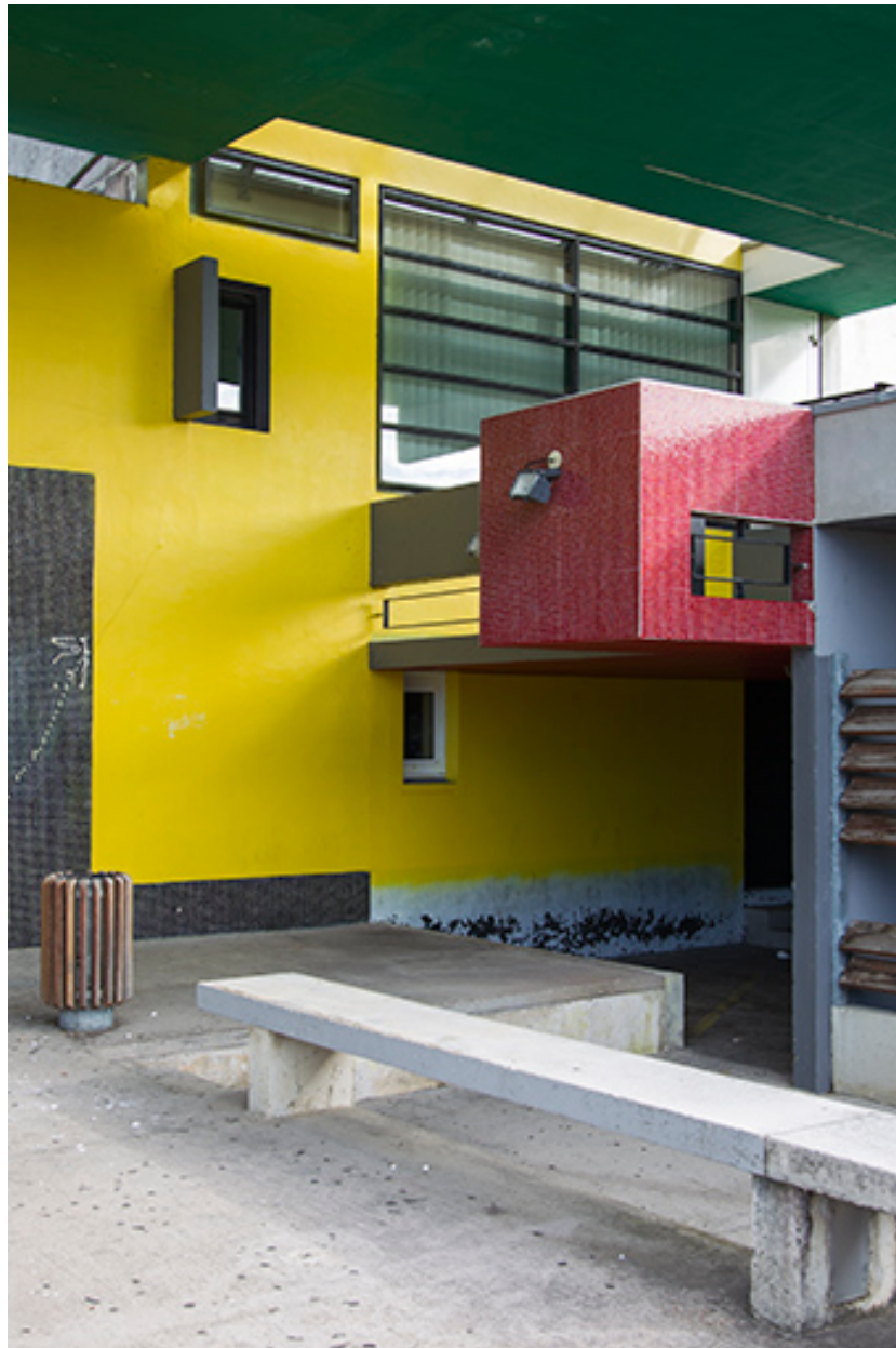
Détail constructif à droite de l'entrée.
