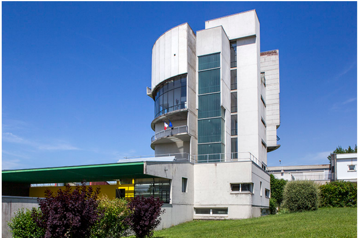
La tour et l'entrée, vues de l'est.
