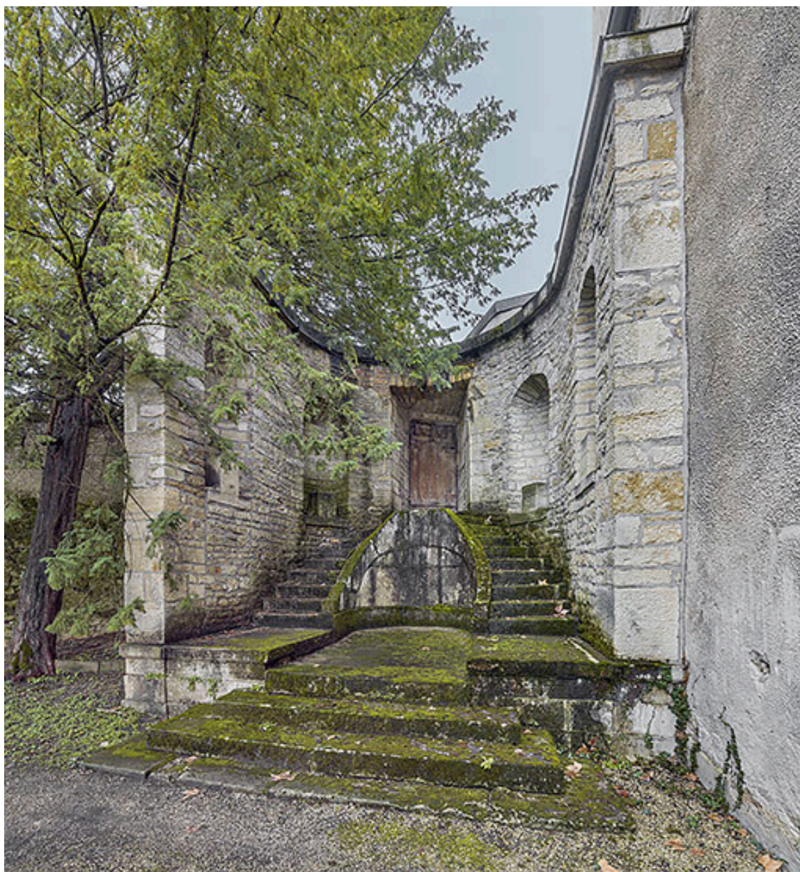
Escalier aménagé pour accéder aux promenades des remparts (accès à la rue Diderot).
