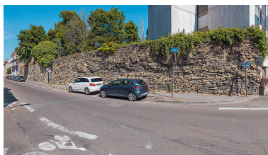
Vestige de la muraille élevée au 12e siècle, rue de Tivoli. Phot. Thierry Kuntz IVR26_20252100400NUC4A
