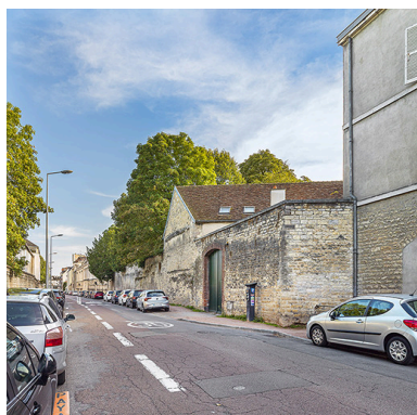
Portion du rempart, rue Diderot.
