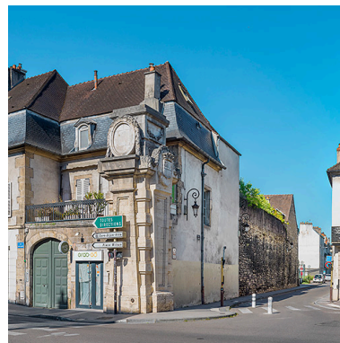
Pilastre de l'ancienne porte de ville Saint-Pierre, rue Chabot-Charny. Phot. Thierry Kuntz IVR26_20252100390NUC4A
