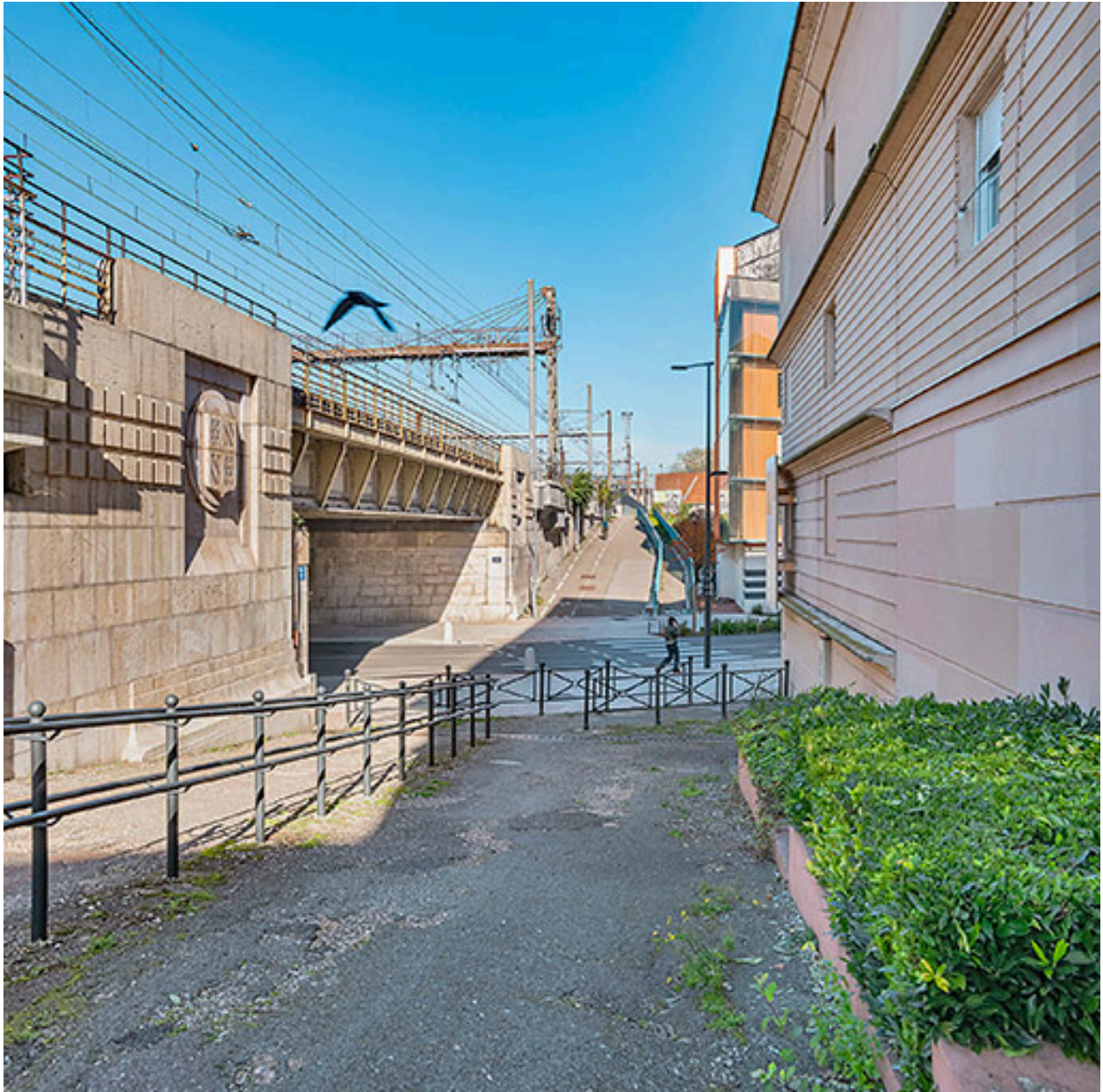
Rampes du rempart Tivoli et de la Miséricorde en face.
