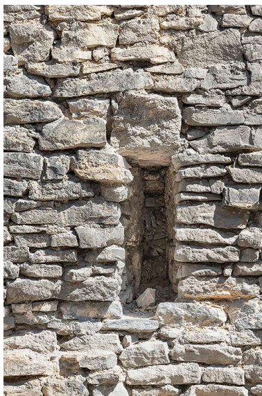
Détail d'une meurtrière, rue de Tivoli. Phot. Thierry Kuntz IVR26_20252100404NUC4A
