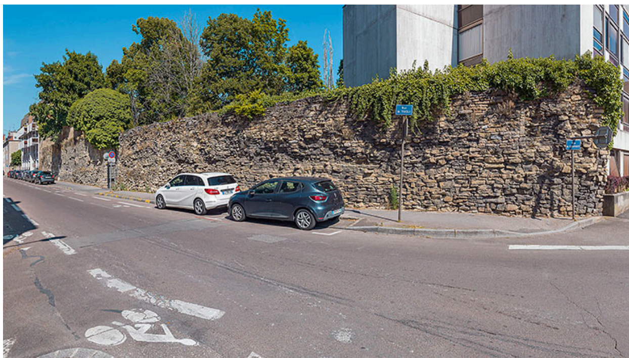
Vestige de la muraille élevée au 12e siècle, rue de Tivoli.
