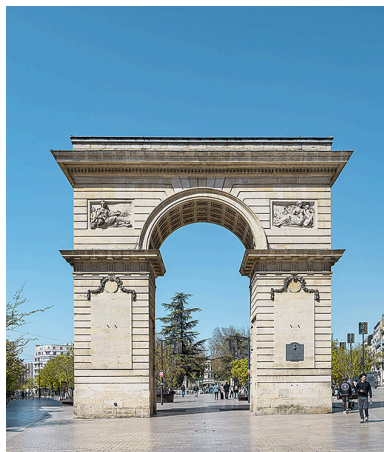
La porte Guillaume reconstruite à la fin du 18e siècle. Phot. Thierry Kuntz IVR26_20252100081NUC4A
