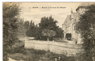
Dijon - Bastion et Terrasse de l'Hôpital. S.d. Repro. Petot Frédéric, Autr. auteur inconnu IVR26_20252100287NUC4A
