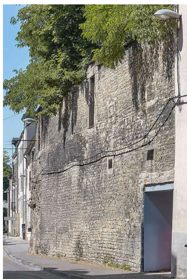
Détail de la maçonnerie du rempart, rue Berlier. Phot. Thierry Kuntz IVR26_20252100093NUC4A
