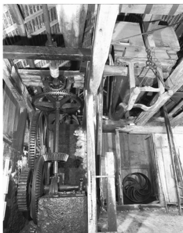
Vue d'un soufflet et du mécanisme. Phot. Yves Sancey
