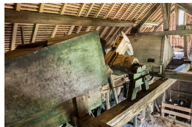
La machine soufflante vue du dessus. Phot. Jérôme Mongreville IVR43_20152501583NUC4A
