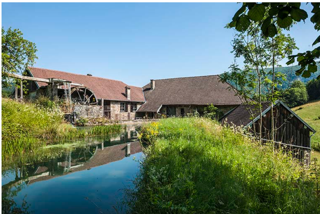
La taillanderie vue depuis le canal d'amenée.
