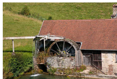
Roue hydraulique de la machine soufflante. Phot. Jérôme Mongreville IVR43_20152501592NUC4A
