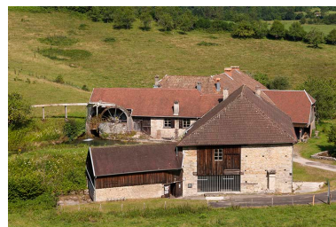
Vue rapprochée depuis l'est. Phot. Jérôme Mongreville IVR43_20152501591NUC4A
