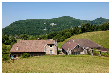
Façades sud des bâtiments. Phot. Jérôme Mongreville IVR43_20152501596NUC4A
