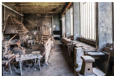
Partie ouest de l'atelier des martinets. Phot. Jérôme Mongreville IVR43_20152501539NUC4A
