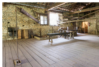
Etage supérieur de l'atelier de forge. A gauche, tige et bras de commande pour l'admission de l'eau sur les roues des martinets. Phot. Jérôme Mongreville IVR43_20152501561NUC4A
