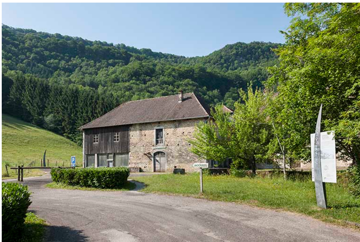
Atelier de fabrication vu depuis le nord.
