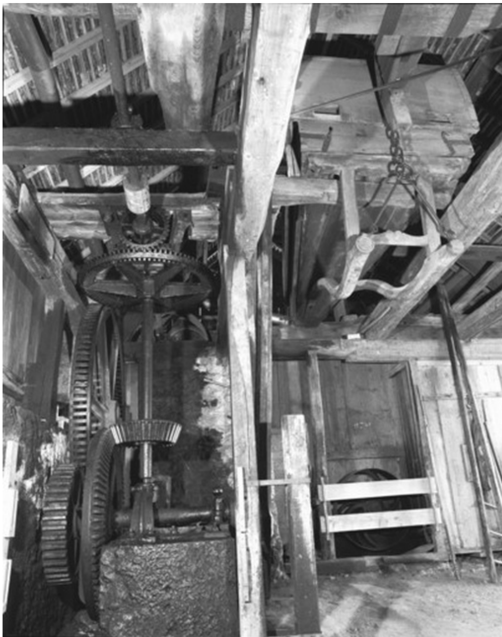
Vue d'un soufflet et du mécanisme.
