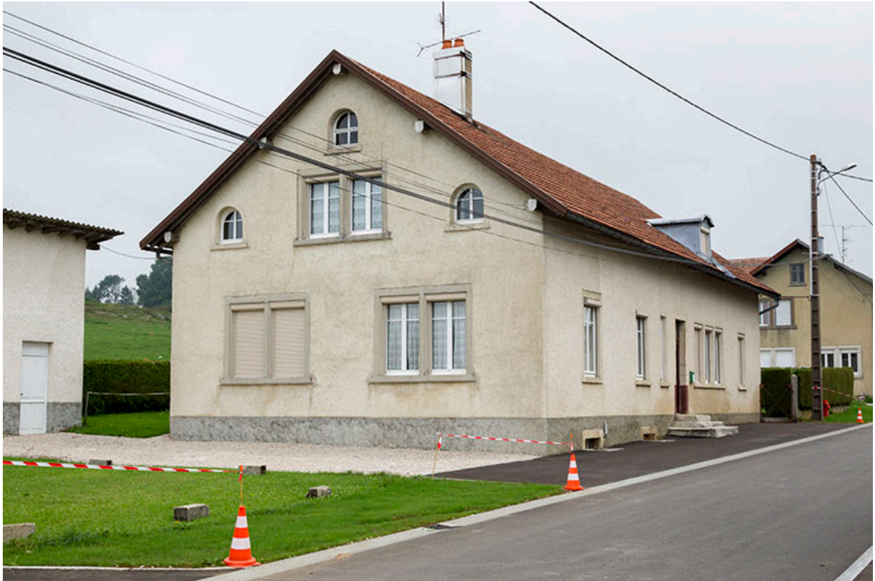
Façades antérieure et latérale gauche.
