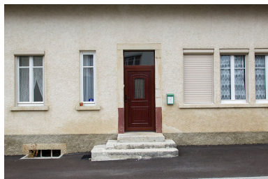
Façade antérieure : porte et fenêtres multiples. Phot. Yves Sancey IVR43_20122502265NUC2A
