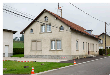
Façades antérieure et latérale gauche. Phot. Yves Sancey IVR43_20122502262NUC2A
