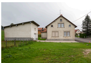
Vue d'ensemble, depuis le sud-ouest (garage et façade latérale gauche du bâtiment). Phot. Yves Sancey IVR43_20122502261NUC2A
