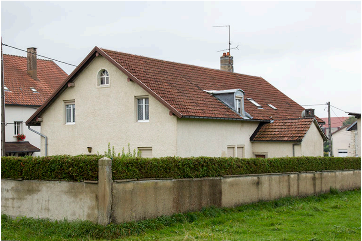
Façades postérieure et latérale droite.
