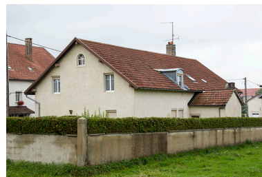
Façades postérieure et latérale droite. Phot. Yves Sancey IVR43_20122502263NUC2A
