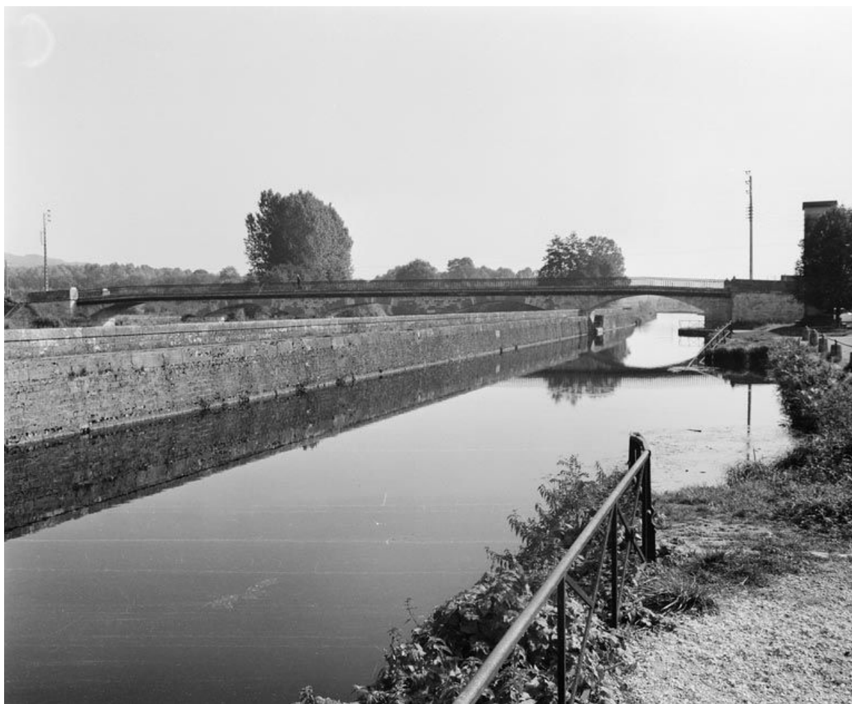
Pont enjambant l'embranchement du canal d'Accolay.
