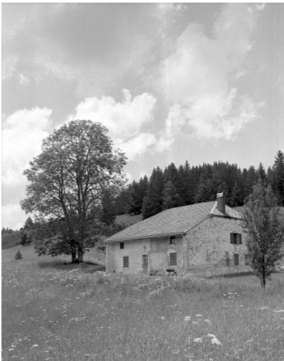
Façade antérieure et face droite.
