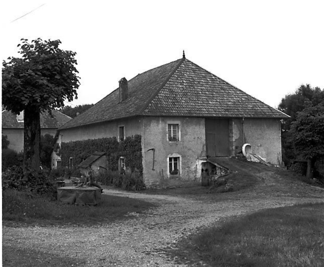
Façade antérieure et face latérale droite.
