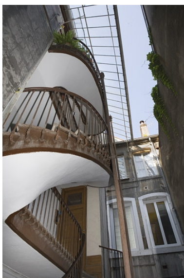
Vue d'ensemble de l'escalier à cage ouverte de la première cour. Phot. Yves Sancey IVR43_20092501388NUC2A
