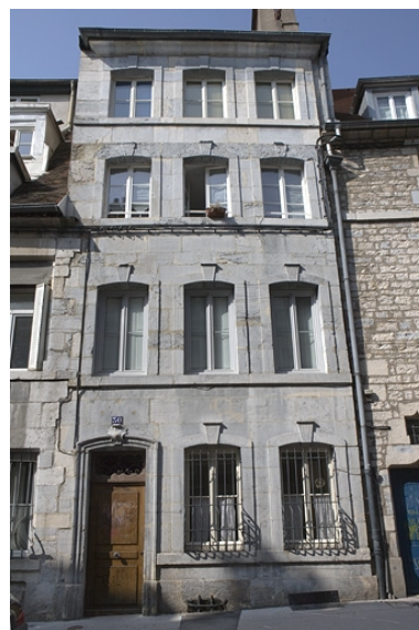
Vue d'ensemble de la façade sur rue, de face. Phot. Yves Sancey IVR43_20092501381NUC2A
