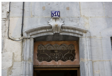
Façade sur rue : détail du dessus de porte du couloir d'entrée. Phot. Yves Sancey IVR43_20092501384NUC2A
