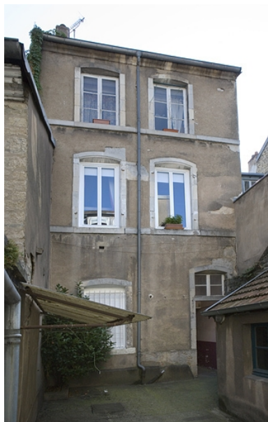
Vue d'ensemble de la façade postérieure du premier logis secondaire. Phot. Yves Sancey IVR43_20092501389NUC2A
