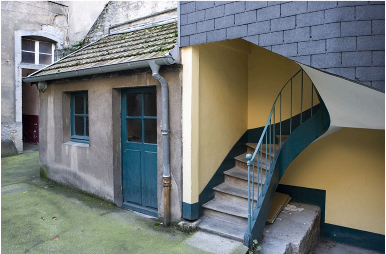
Détail de la buanderie dans la deuxième cour.
