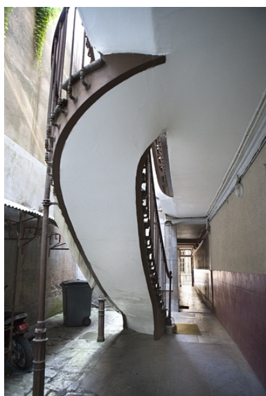
Détail de l'escalier à cage ouverte sur cour, depuis le fond de la première cour. Phot. Yves Sancey IVR43_20092501386NUC2A
