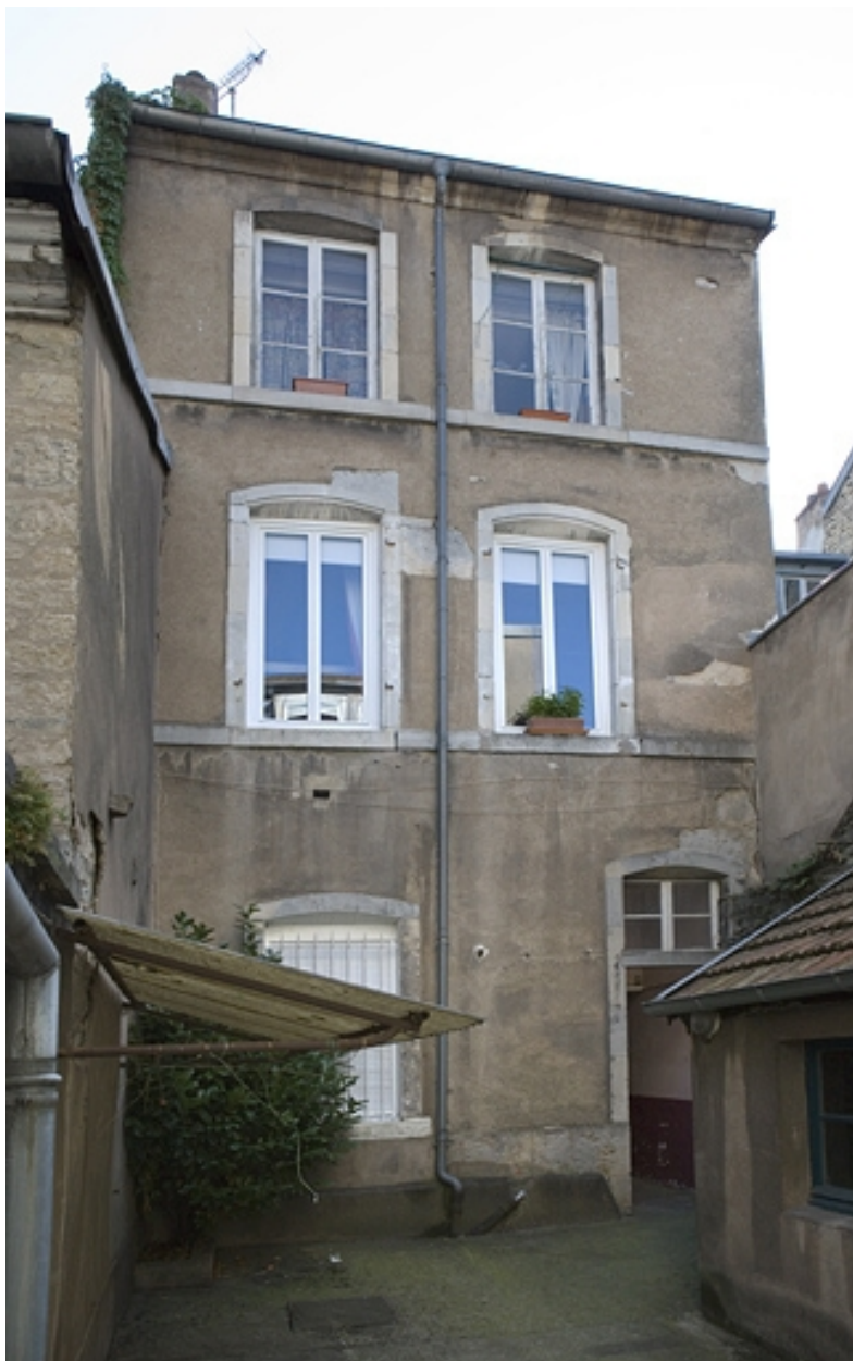
Vue d'ensemble de la façade postérieure du premier logis secondaire.
