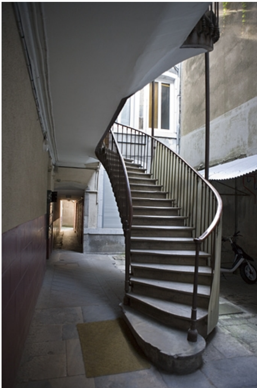
Détail de l'escalier à cage ouverte sur cour, depuis l'entrée de la première cour.
