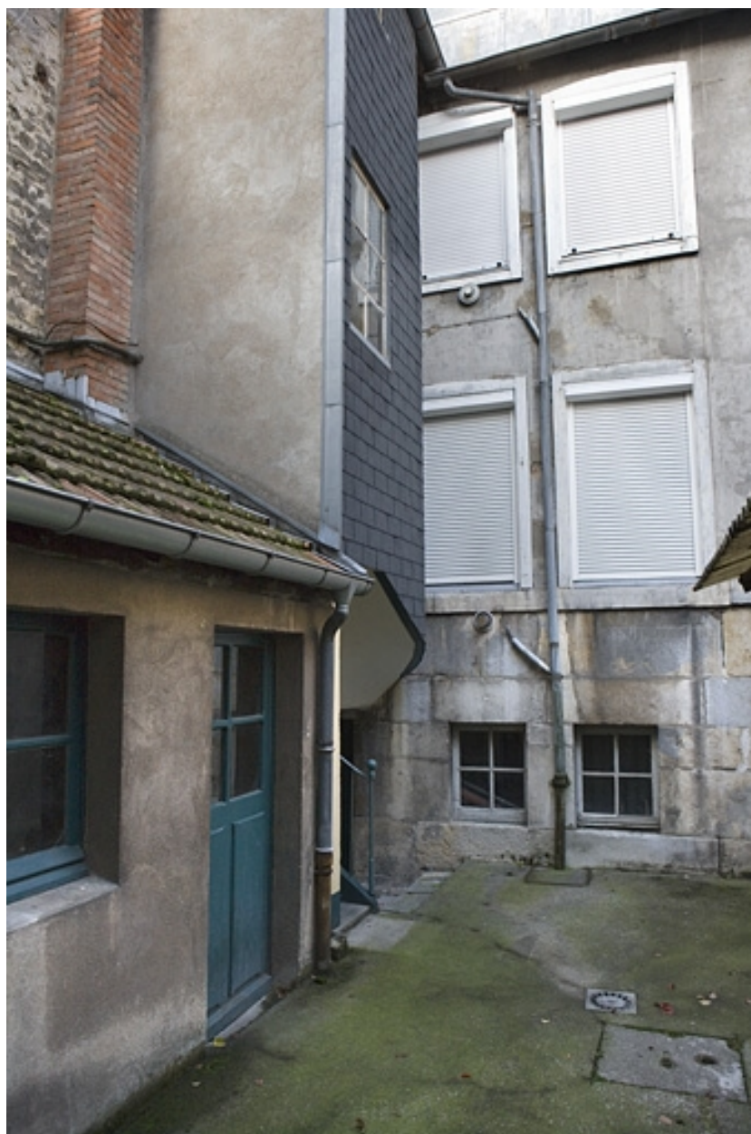
Vue d'ensemble de la façade antérieure du deuxième logis secondaire.
