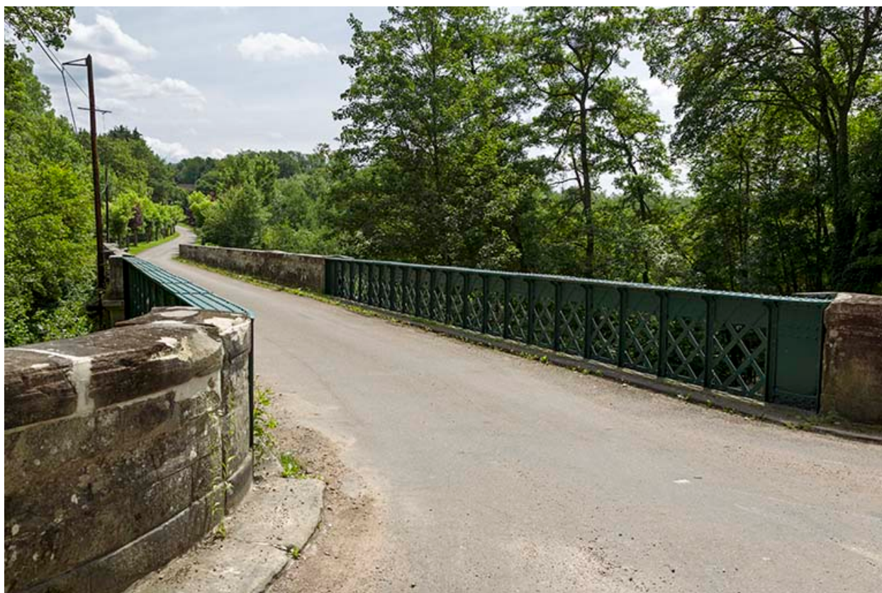
Vue de la passerelle depuis la route.
