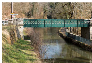
Vue sur la passerelle enjambant le canal.
