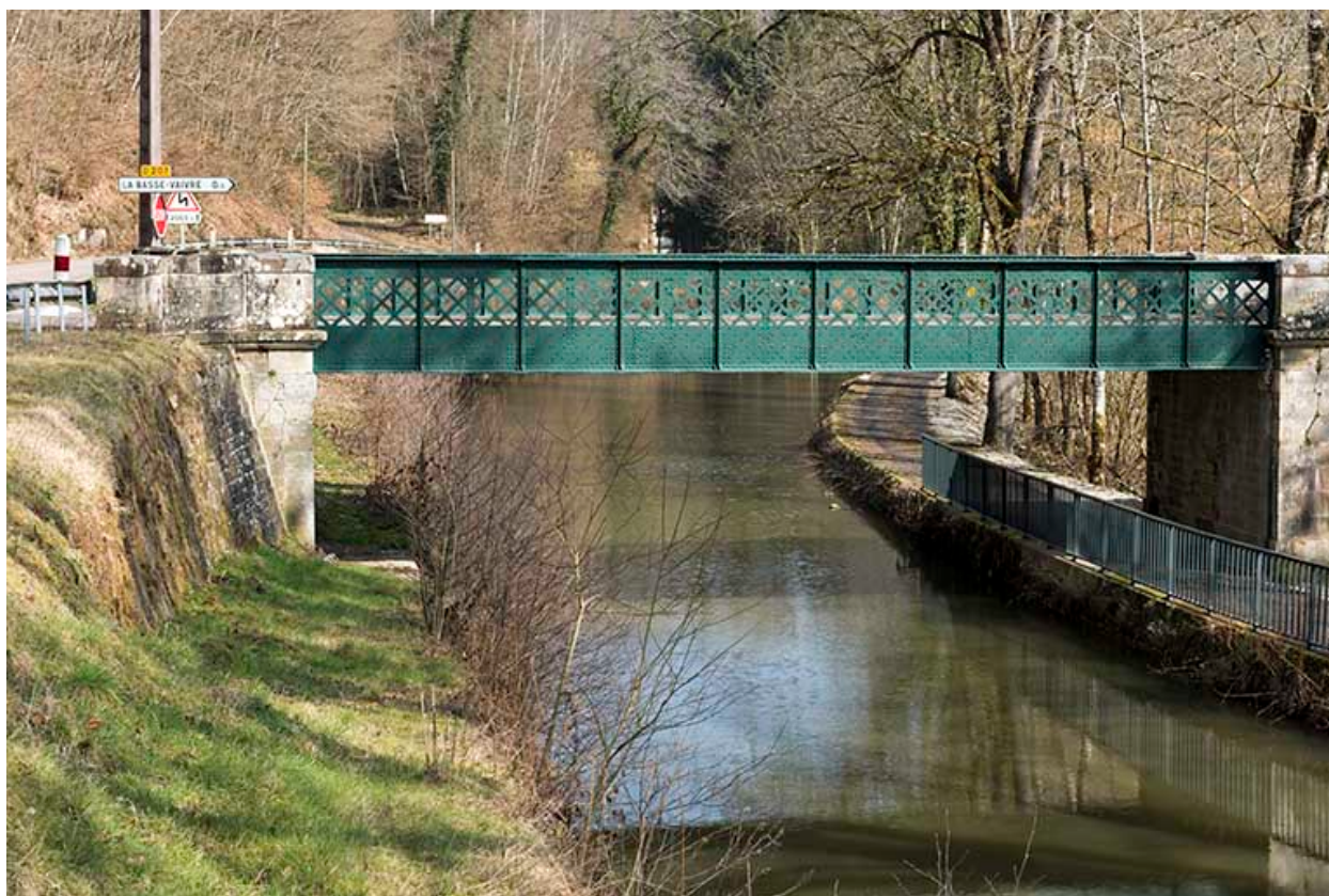
Vue sur la passerelle enjambant le canal.
