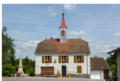
Mairie, ancienne école, ancienne maison commune,
