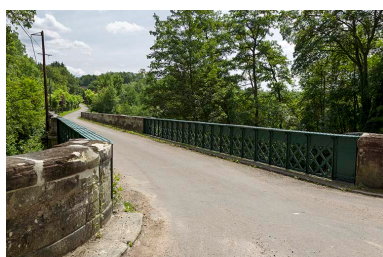
Vue de la passerelle depuis la route.
