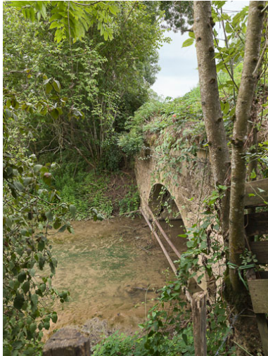
Vue de l'aqueduc. Phot. Pierre-Marie Barbe-Richaud IVR26_20175800219NUC2A
