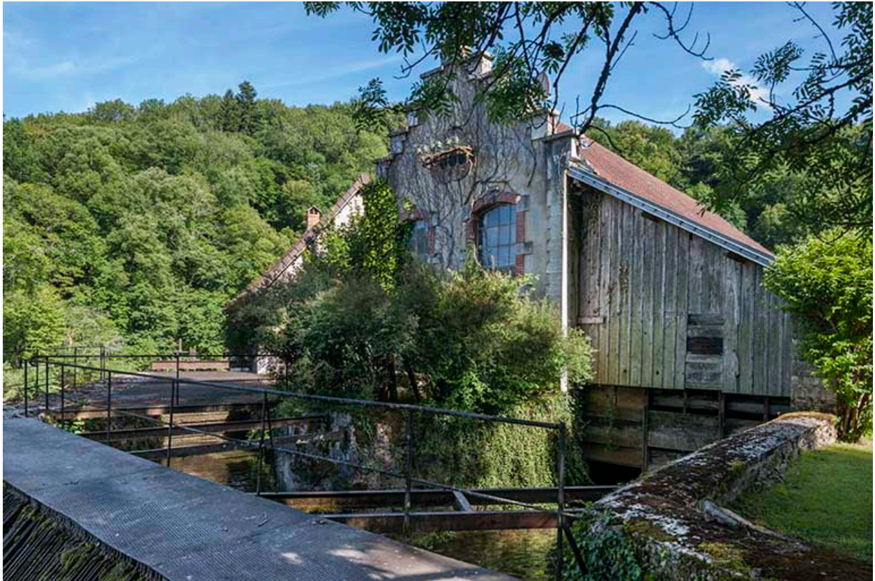
Prise d'eau, centrale hydroélectrique et bâtiment d'eau.
