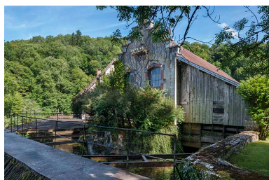
Prise d'eau, centrale hydroélectrique et bâtiment d'eau. Phot. Jérôme Mongreville IVR43_20152501625NUC4A
