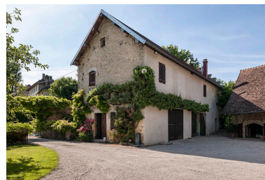
Atelier de fabrication, puis centrale hydroélectrique. Phot. Jérôme Mongreville IVR43_20152501623NUC4A
