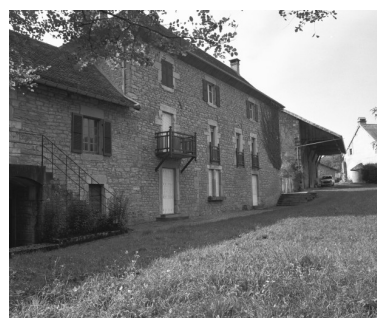
Vue de trois quarts gauche de l'habitation en 1980. Phot. Yves Sancey IVR43_19792501178V
