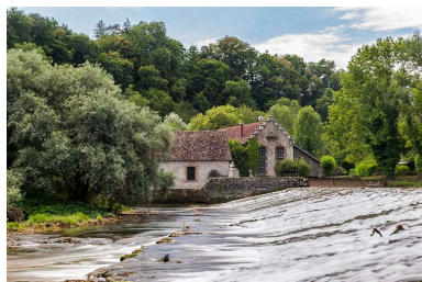
Vue d'ensemble depuis l'extrémité du barrage, au nord. Phot. Jérôme Mongreville IVR43_20152501628NUC4A
