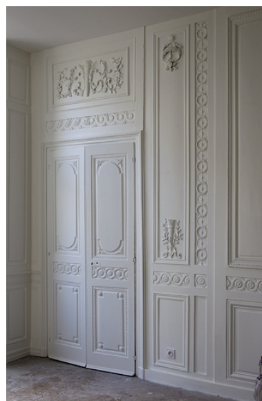
Intérieur : détail d'une partie des lambris d'un salon, au rez- de-chaussée de l'aile gauche. Phot. Yves Sancey IVR43_20122501416NUC2A
