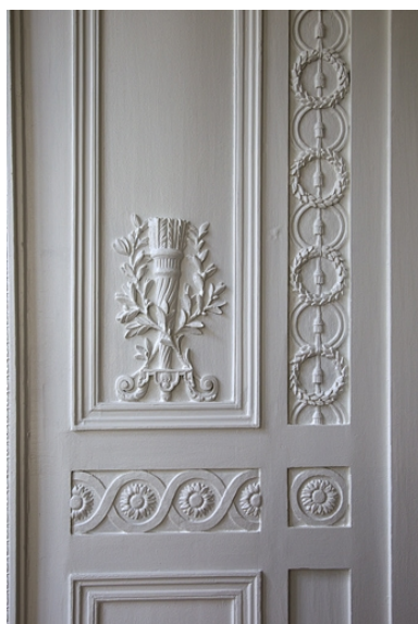
Intérieur, salon du rez-de- chaussée de l'aile gauche : détail du décor d'un panneau de lambris. Phot. Yves Sancey IVR43_20122501417NUC2A
