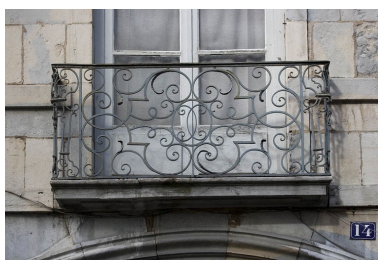
Détail du balcon en fer forgé. Phot. Yves Sancey IVR43_20072500170NUCA
