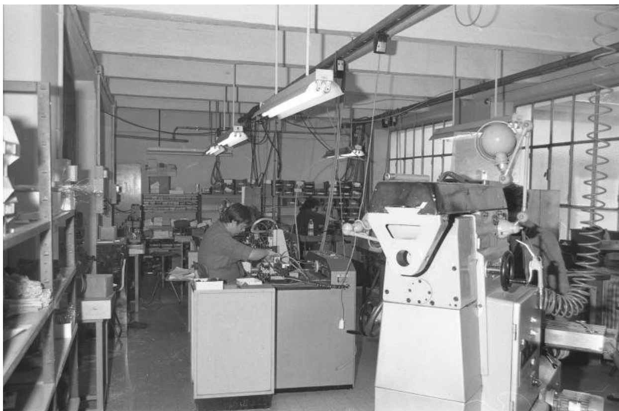
Intérieur d'un atelier dans le bâtiment d'origine.
