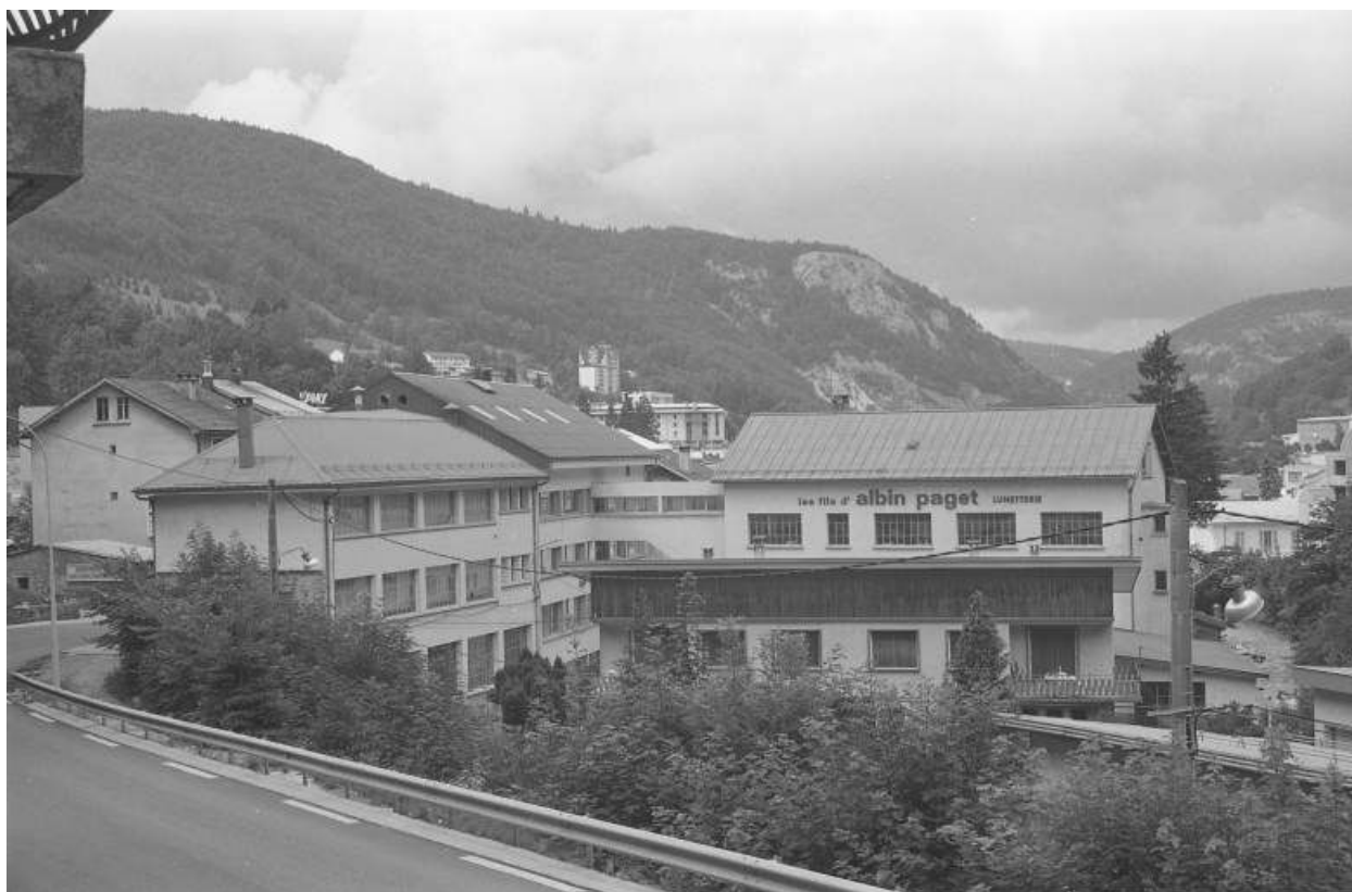
Bâtiments vus du sud.
