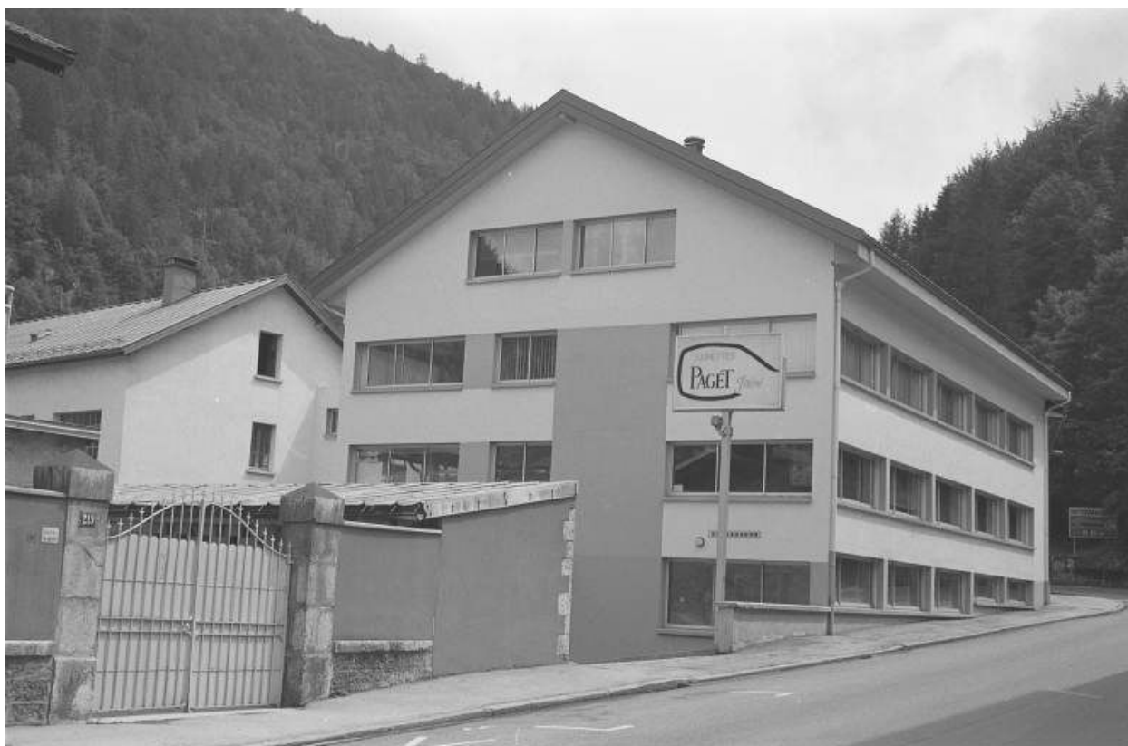
Façades postérieure et latérale droite des bureaux.
