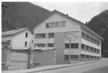
Façades postérieure et latérale droite des bureaux.
