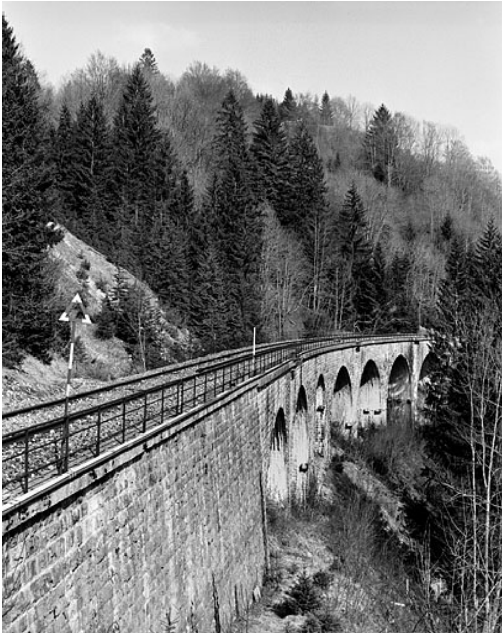
Elévation sud vue en enfilade, depuis le sud-ouest (côté Andelot-en-Montagne).
