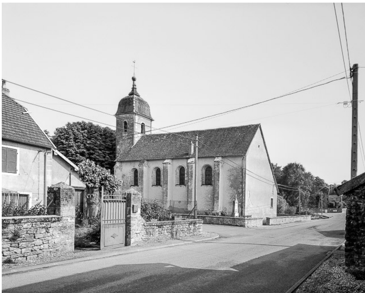
Façade latérale droite et chevet.
