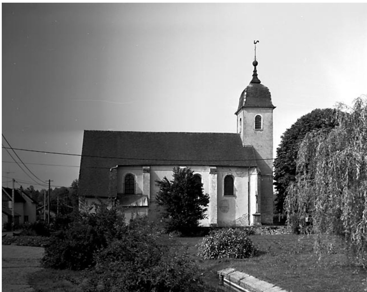
Façade latérale gauche.
