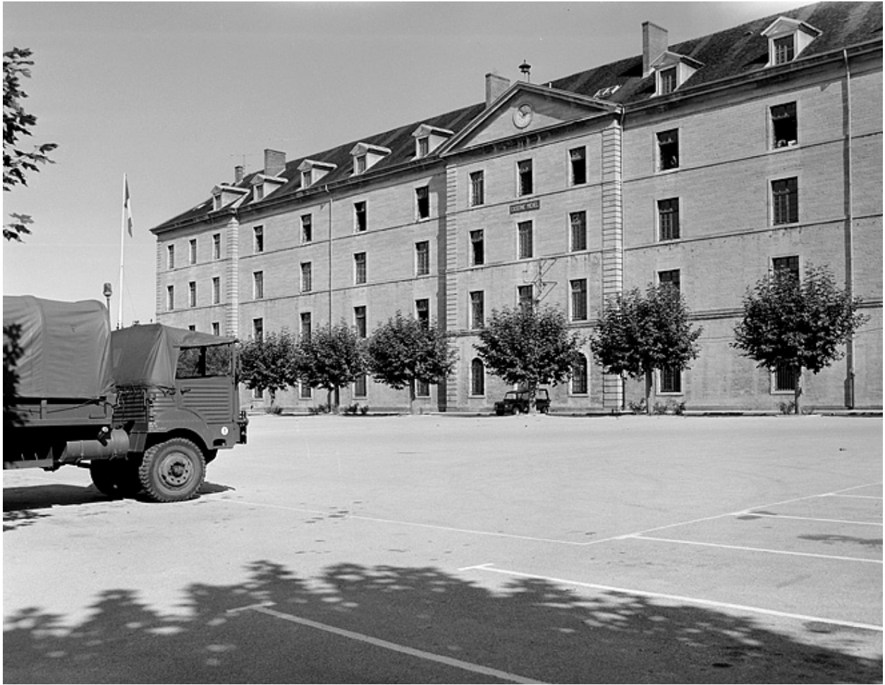
Façade antérieure, partie gauche.
