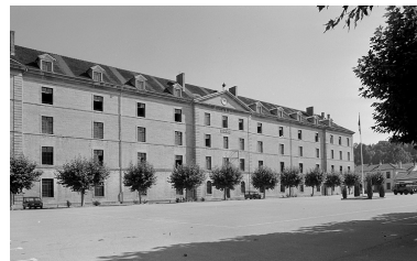
Façade antérieure, partie droite. Phot. Yves Sancey IVR43_19833900512X
