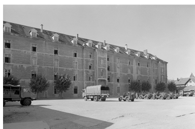
Façade postérieure. Phot. Yves Sancey IVR43_19833900513X
