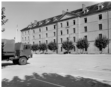
Façade antérieure, partie gauche. Phot. Yves Sancey IVR43_19833900511X
