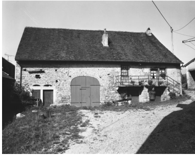
Façade antérieure. Phot. Dominique Dominguez IVR43_19803900018X
