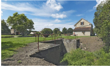
L'aqueduc avec en arrière-plan, la maison éclusière.
