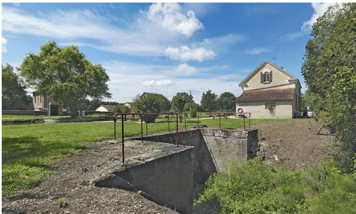
L'aqueduc avec en arrière-plan, la maison éclusière.
