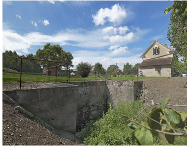
Maçonnerie de l'entrée de l'aqueduc.
