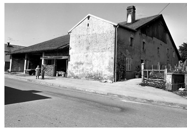
Ferme située rue de Besançon : vue d'ensemble. Phot. Bernard Lardière IVR43_19782500336X
