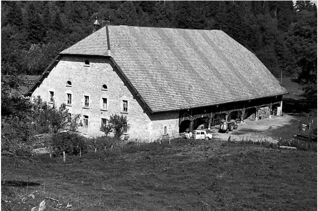
Ferme située au lieudit Gros Maillot : vue d'ensemble.
