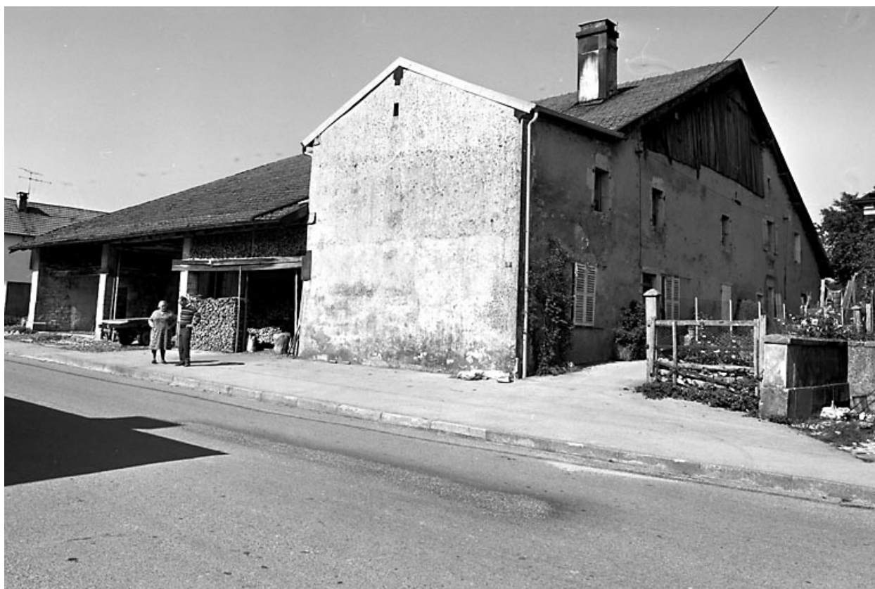
Ferme située rue de Besançon : vue d'ensemble.
