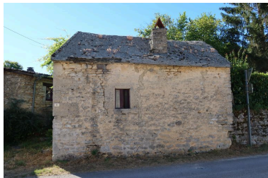
Vue de la façade depuis le nord-est. Phot. Morgane Guillemain IVR26_20222101149NUC2A
