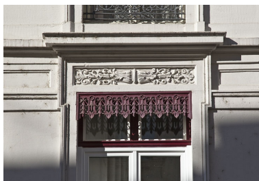
Façade antérieure : détail d'un linteau et du lambrequin de store d'une fenêtre. Phot. Yves Sancey IVR43_20122500559NUC2A
