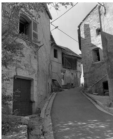
Maison située rue de la Reine. Phot. Yves Sancey IVR43_19802500985X
