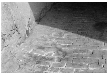
Maison ni repérée ni sélectionnée (AC 115, 116) : sol en bois du passage couvert. Phot. Liliane Hamelin IVR43_19992500160Z
