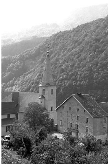
Maison située rue de l'Eglise.
