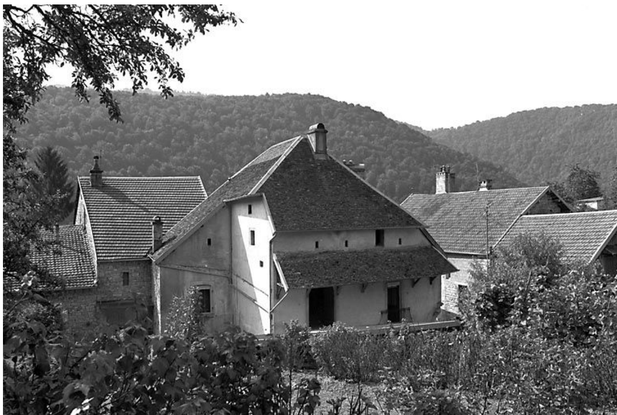
Maison située rue de Jaubourg.
