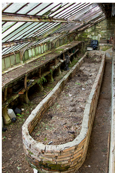
L'intérieur de la serre accolée à la façade sud.
