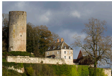
Vue générale depuis le sud avec, de gauche à droite, le donjon, le "nouveau château" et le "vieux château". Phot. Sonia Dourlot IVR43_20167000735NUC2A
