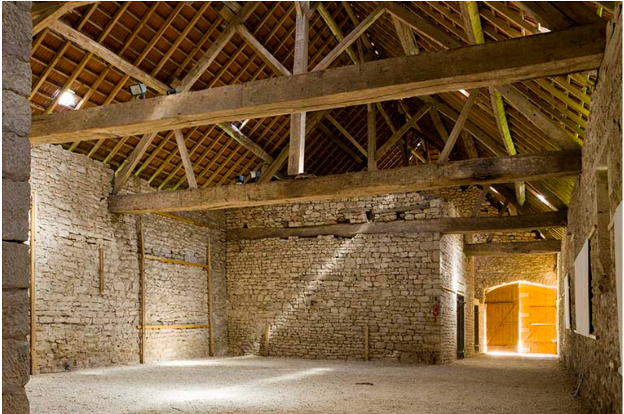
Intérieur du cuvage, en direction du sud-est.
