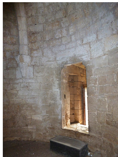
Intérieur du donjon : la salle voûtée d'ogives et la porte ouvrant sur l'escalier. Phot. Sonia Dourlot IVR43_20177000517NUC2A
