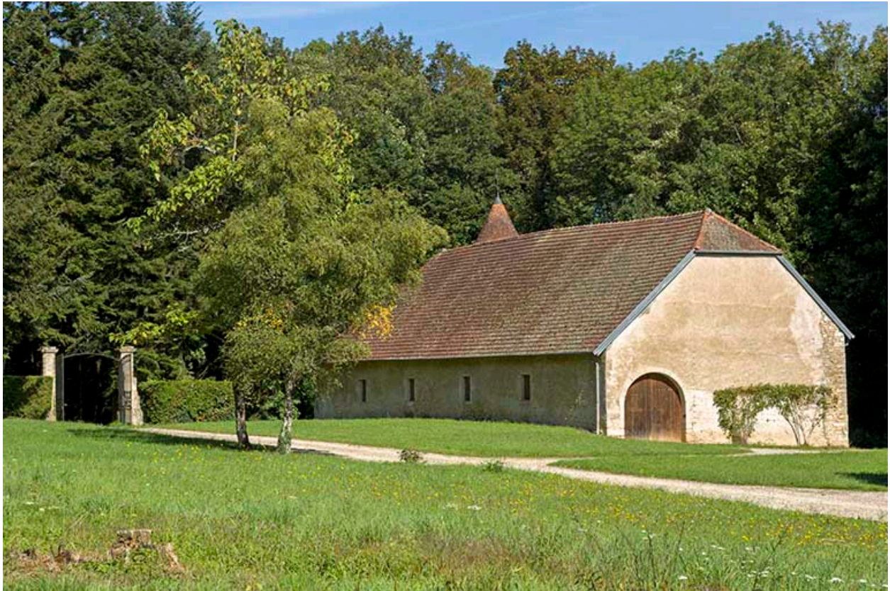
Vue générale du cuvage.
