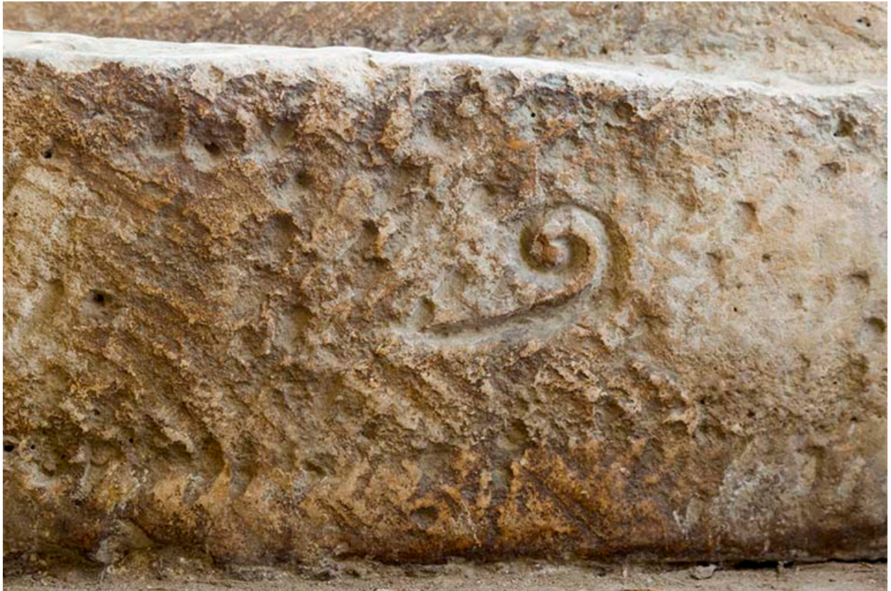
Intérieur du donjon : marque lapidaire sur une des contremarches de l'escalier.
