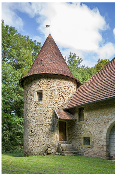
La tour à l'angle nord-est du cuvage. Phot. Sonia Dourlot IVR43_20167000745NUC2A
