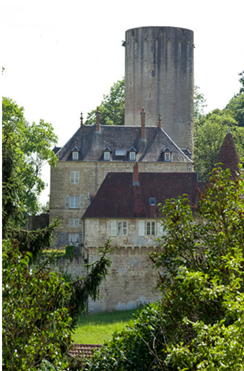
Vue générale depuis le parvis de l'église : "vieux château", "nouveau château" et donjon.
