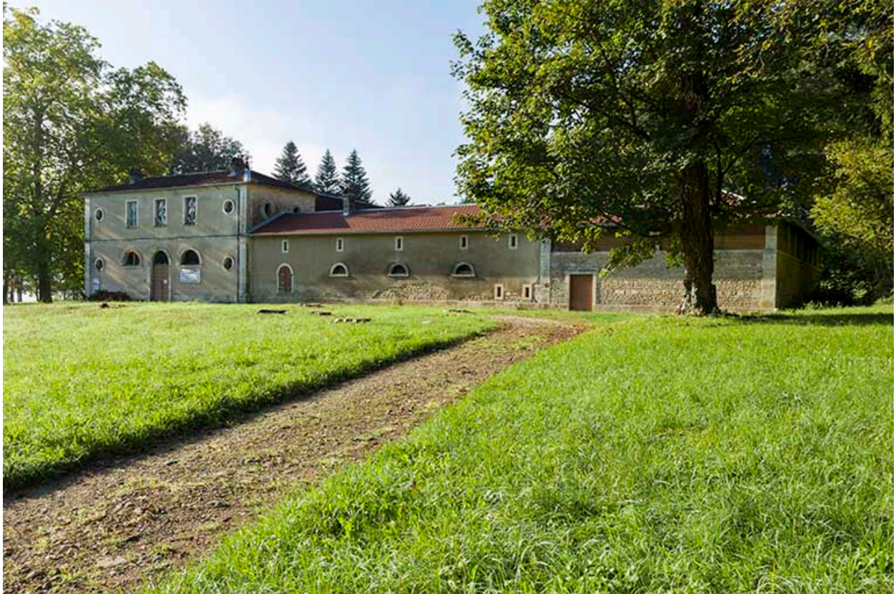
Façade latérale droite de la ferme.
