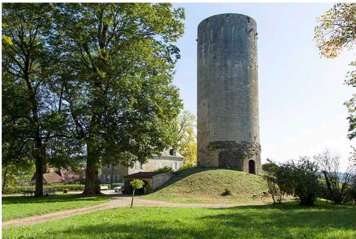
Vue générale du donjon depuis le parc.
