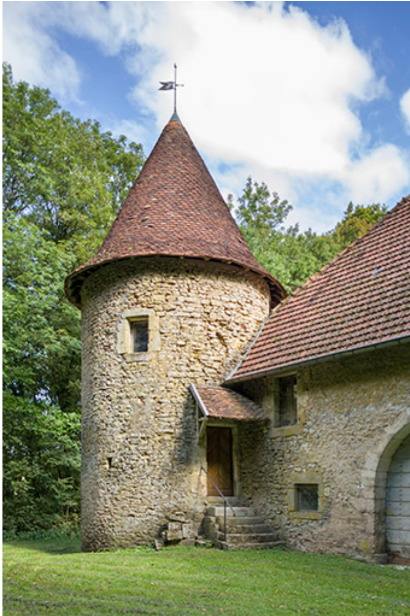
La tour à l'angle nord-est du cuvage.
