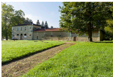
Façade latérale droite de la ferme. Phot. Sonia Dourlot IVR43_20167000761NUC2A
