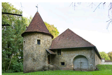
L'entrée du cuvage et la tourelle située au nord-est. Phot. Sonia Dourlot IVR43_20167000744NUC2A
