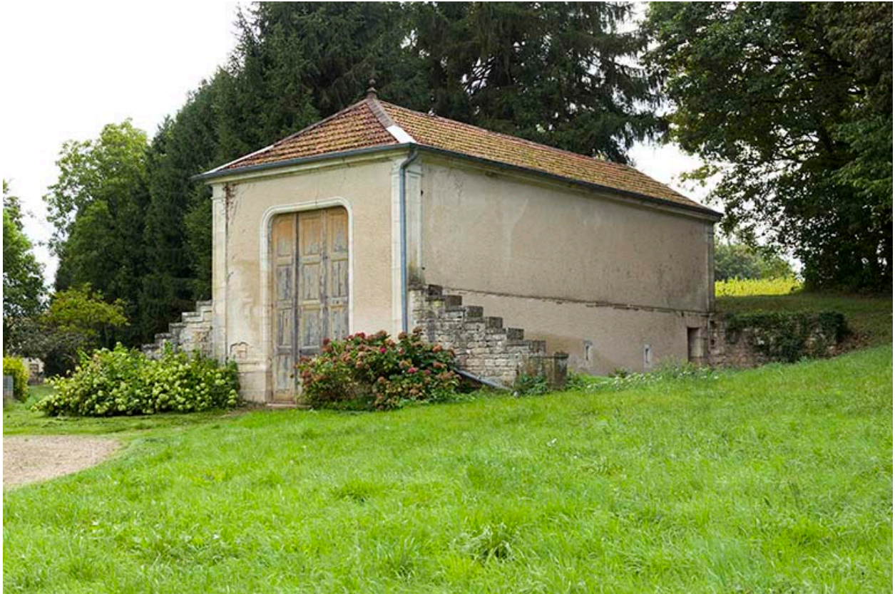
Vue générale nord-est de l'orangerie et des vestiges de la seconde serre.
