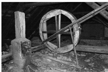
Combles : l'un des treuils. Phot. Jérôme Mongreville IVR43_20003900754Z
