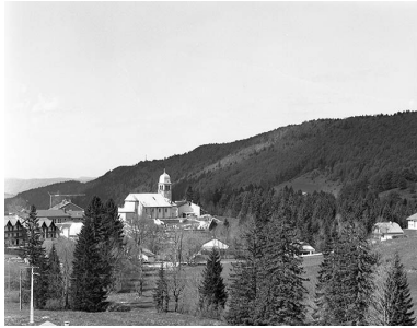
Vue de situation. Phot. Jérôme Mongreville IVR43_20003900581X
