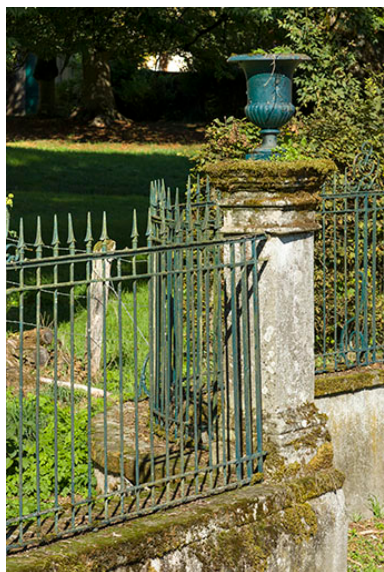
Détail de la clôture orientale.
