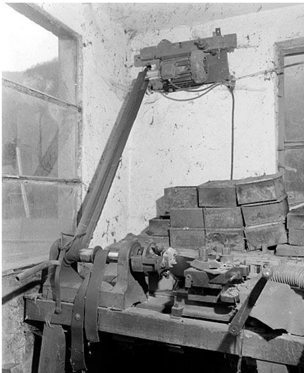
Vue d'ensemble avec son moteur.
